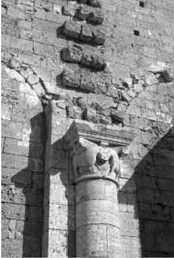
5. Castelnuovo dell'Abate, abbazia di Sant'Antimo, elementi decorativi in facciata.
