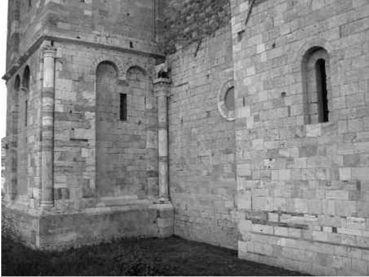
1. Castelnovo dell'Abate, abbazia di Sant'Antimo, innesto della parete settentrionale sul campanile.
