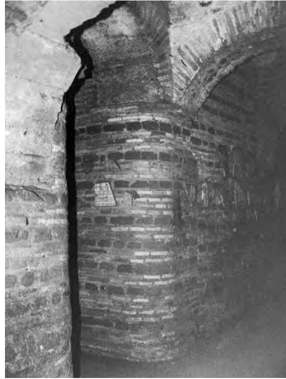
Fig. 203 - Spelunca magna , angoli murari stondati all'incrocio con l'ambulacro AB10.
