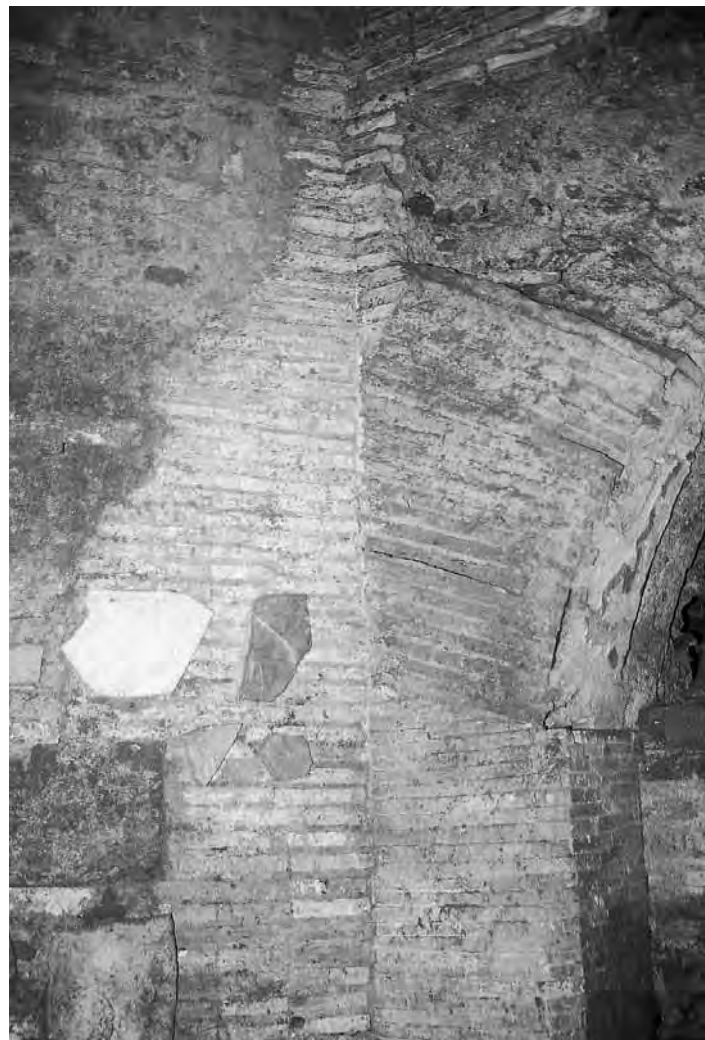
Fig. 65 - Angolo interno sud-est del vano Ac.
