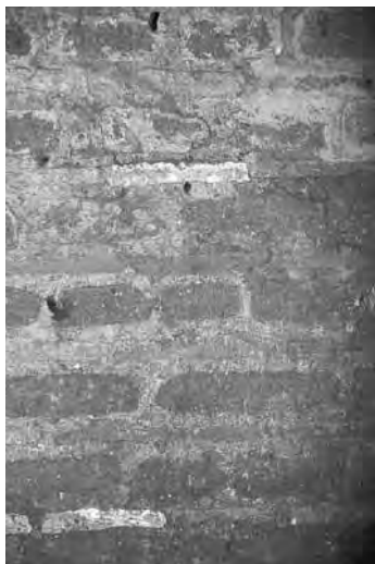
Fig. 214 - Murature sulla spelunca magna . Opera listata 1tuf/1lat.
