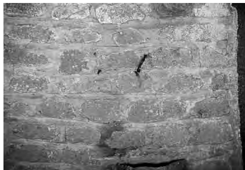
Fig. 212 - Murature sulla spelunca magna . Opera a prevalenza di tuffelli.
