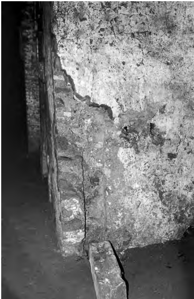
Fig. 193 - Spelunca magna , abside Ag: incasso contestuale alla costruzione muraria per la messa in opera della testata di una transenna marmorea.
