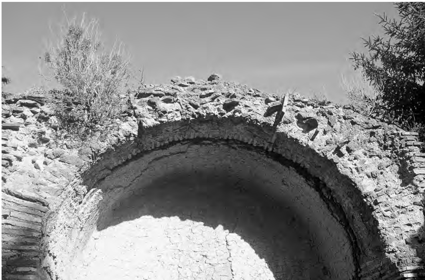
Fig. 328 - Mausoleo cruciforme: ghiera dell'arcone orientale con laterizi asportati.
