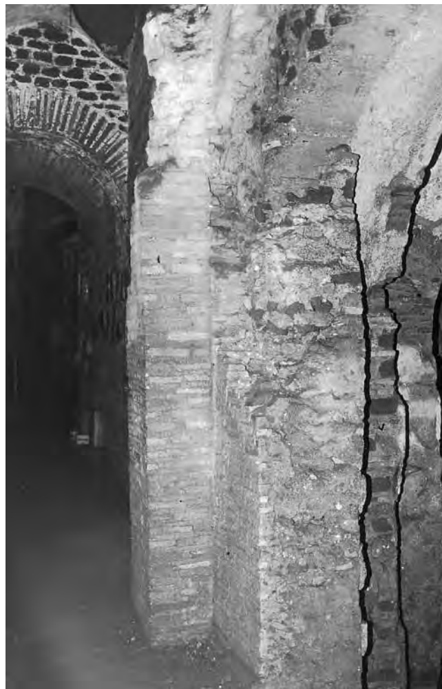
Fig. 219 - Murature sulla spelunca magna . Pilastro in laterizio in prossimità del cubicolo Ax.
