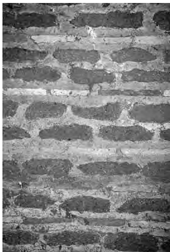
Fig. 211 - Murature sulla spelunca magna . Opera listata 2tuf/1lat.
