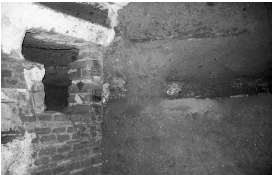
Fig. 158 - Cubicolo Aox: parete ovest.
