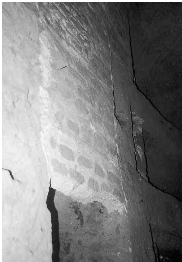
Fig. 152 - Resto del muro in tufelli di sbarramento della galleria G8.
