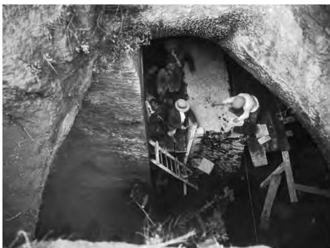
Fig. 347 - Frana nella regione I: operai al lavoro in prossimità del lucernario della galleria I1/I2 (Archivio PCAS).
