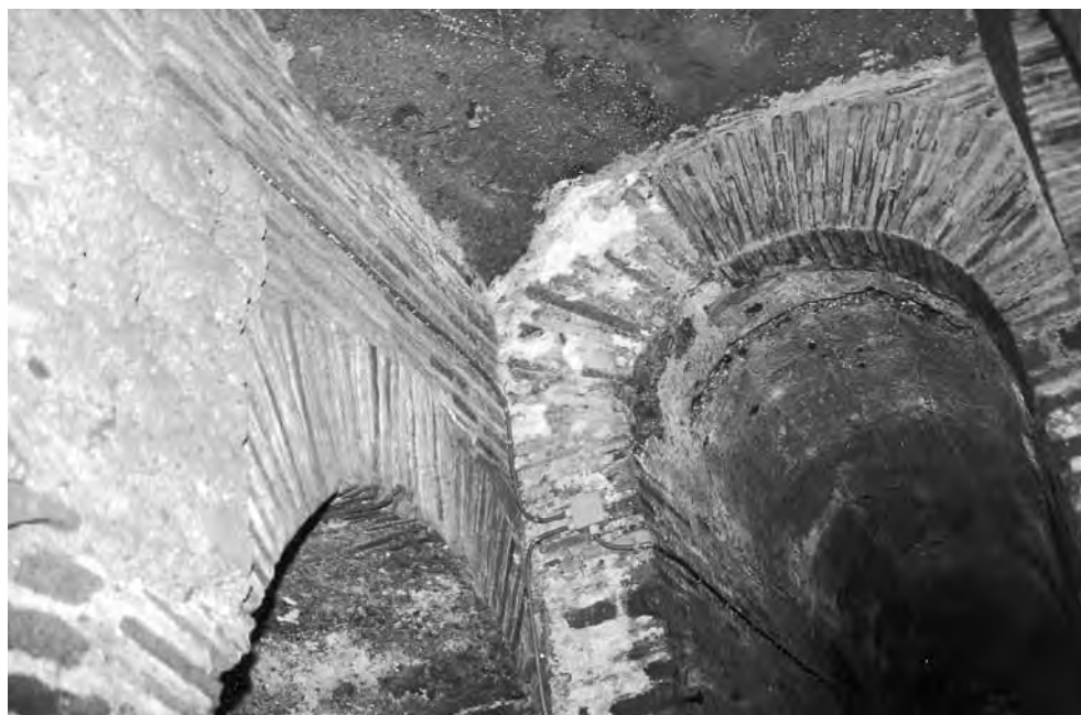
Fig. 215 - Spelunca magna . Particolare della volta del settore orientale con tracce di centina.
