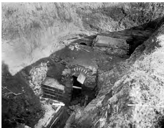
Fig. 353 - Frana del 1936 nelle gallerie del gruppo AB (Archivio PCAS).
