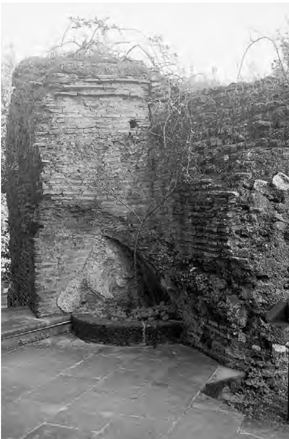
Fig. 318 - Strutture esterne addossate al mausoleo cruciforme.
