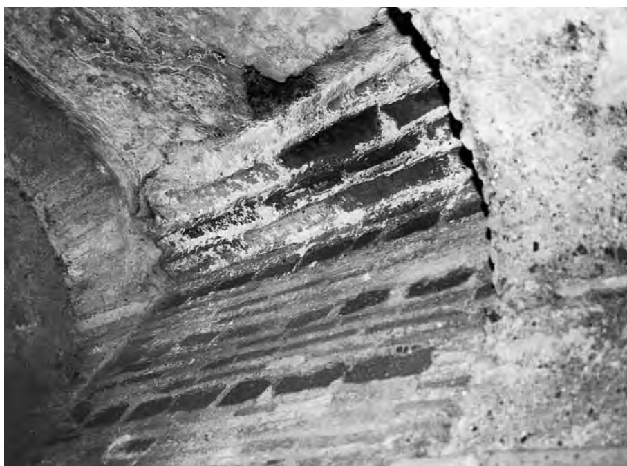
Fig. 207 - Galleria AB10: particolare della modanatura laterizia superiore.
