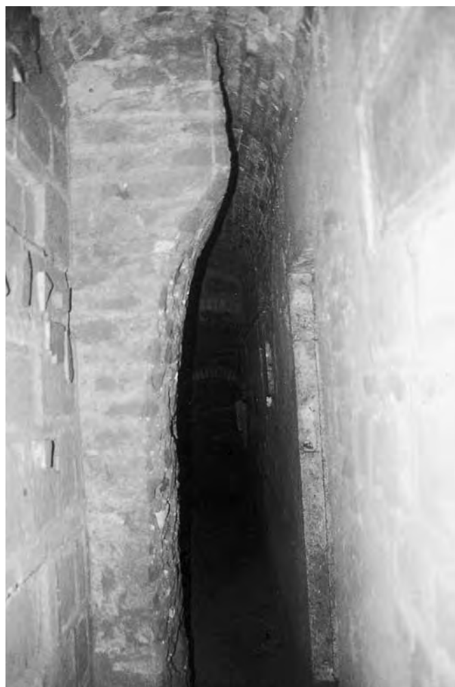
Fig. 313 – Pilastro pertinente ad una costruzione subdiale ancora visibile dalla catacomba, adeguatamente tagliato per favorire il passaggio nella galleria DA8.
