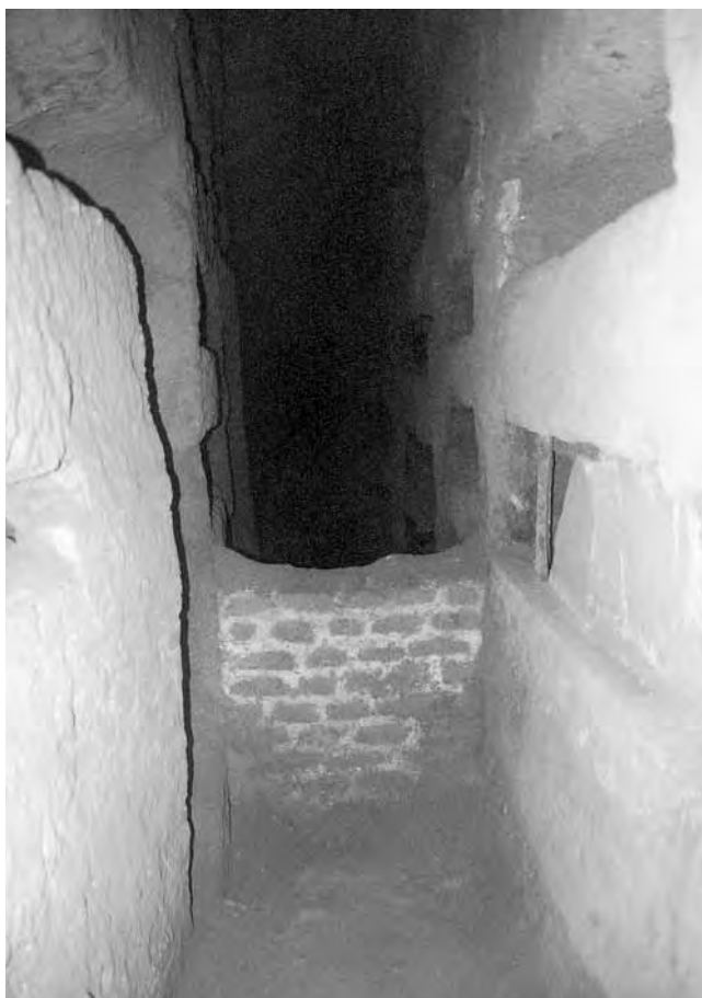
Fig. 151 - Muro in tufelli dell'ambulacro G9 pertinente alla fase di utilizzo del vano come ossario.
