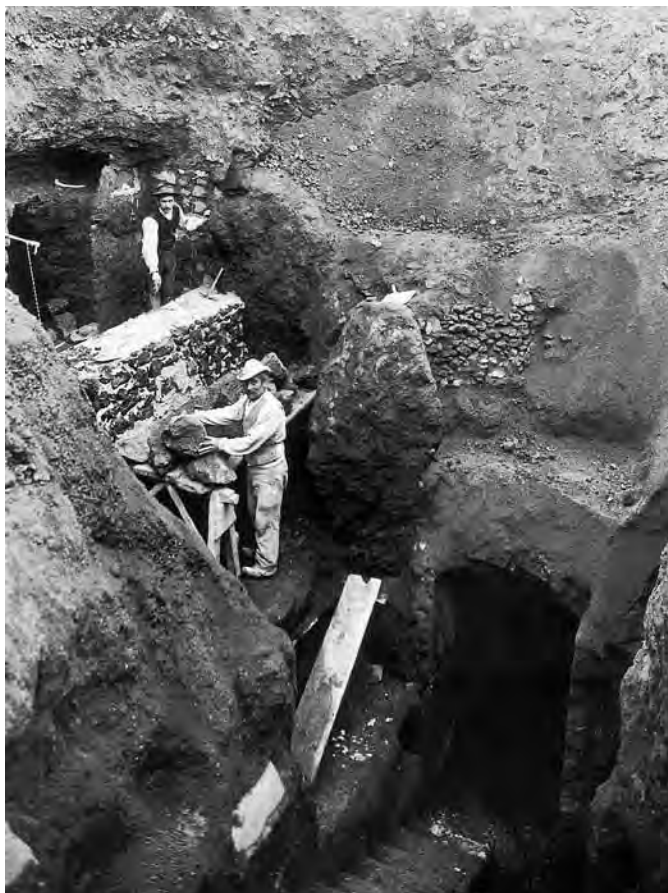
Fig. 354 - Frana del 1936 nelle gallerie del gruppo AB (Archivio PCAS).
