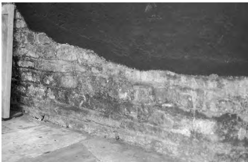
Fig. 300 - Resto in opera listata del muro orientale dell'edificio sub divo .
