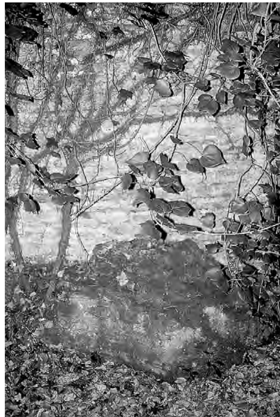
Fig. 319 - Strutture esterne addossate al mausoleo esaconco.
