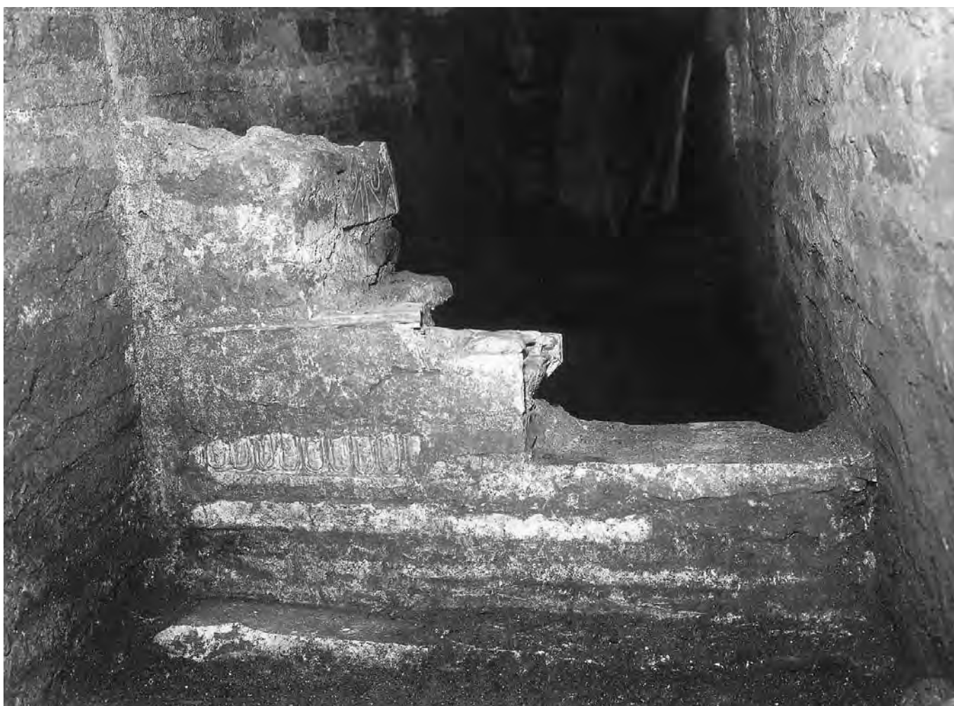
Fig. 327 - Muro di sbarramento della galleria AB10 (Archivio PCAS).
