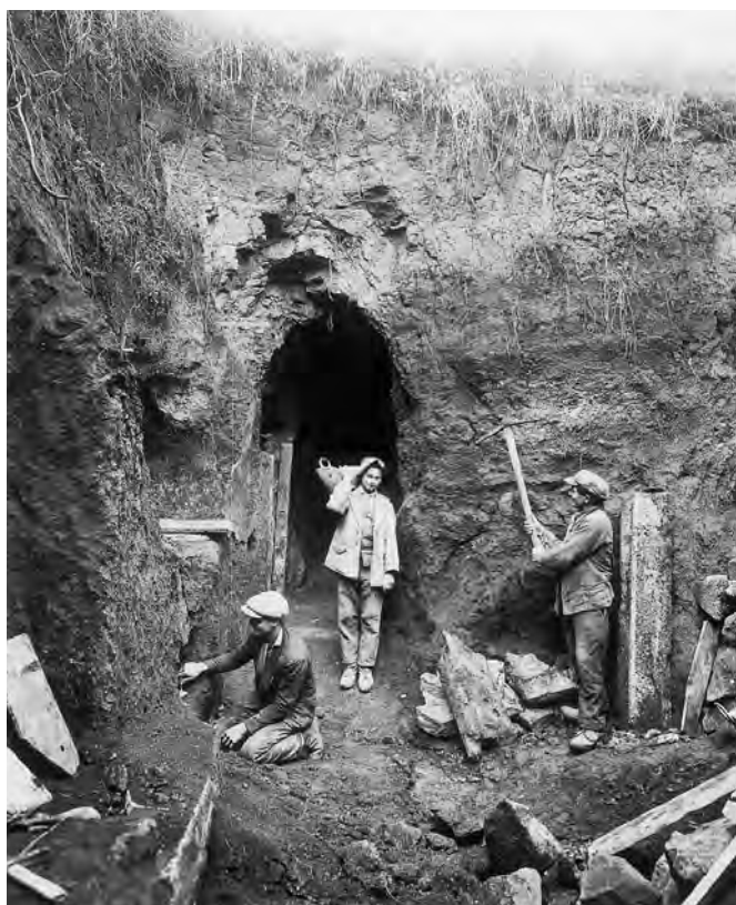
Fig. 348 - Frana nella regione I: operai al lavoro in prossimità del lucernario della galleria I1/I2 (Archivio PCAS).
