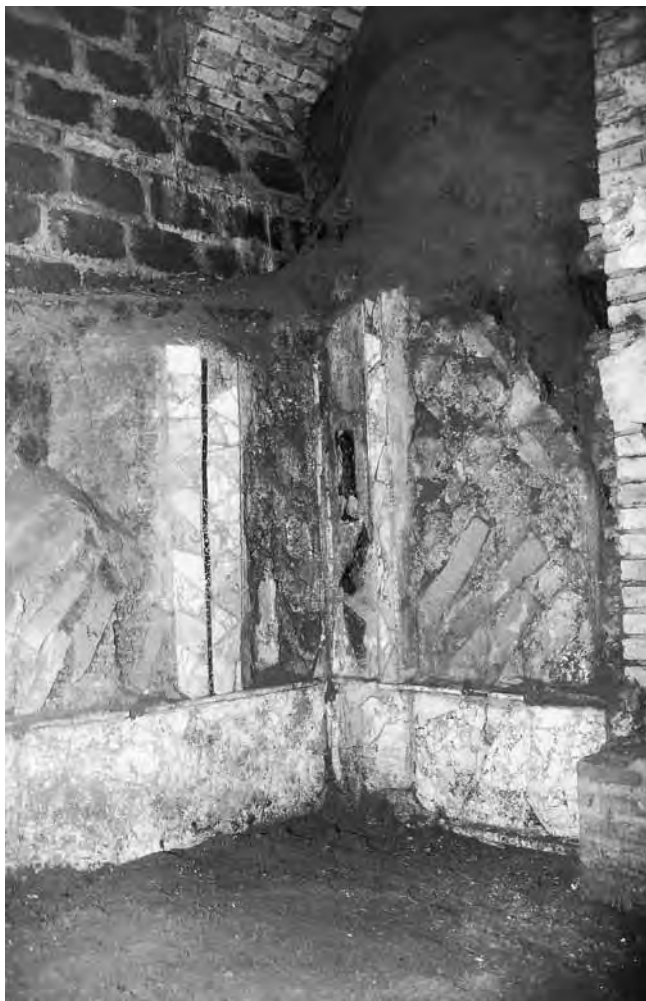
Fig. 228 - Cubicolo Ao: particolare dell'angolo sud-est con resti del rivestimento marmoreo.
