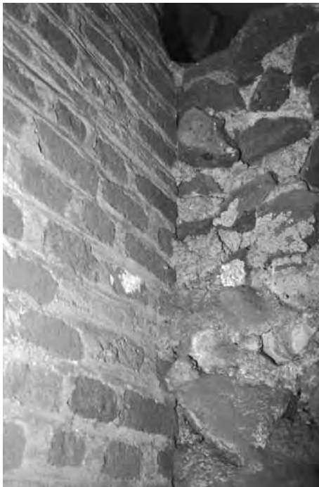
Fig. 265 - Struttura in peperini oclusiva di Do1 da Da7: particolare dell'addossamento ai muri di foderatura parietale.
