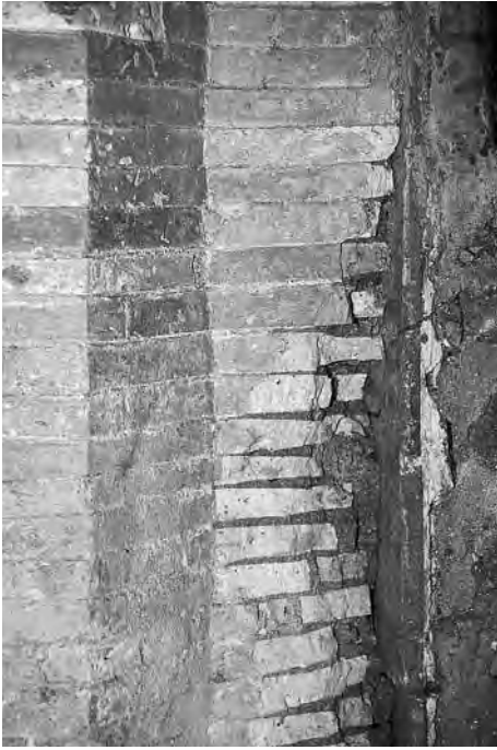
Fig. 56 - Particolare dell'opera laterizia del prospetto Ac: mattoni "a coda di rondine".
