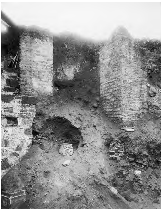
Fig. 312 – Pilastri nella galleria DA8 (Archivio PCAS).
