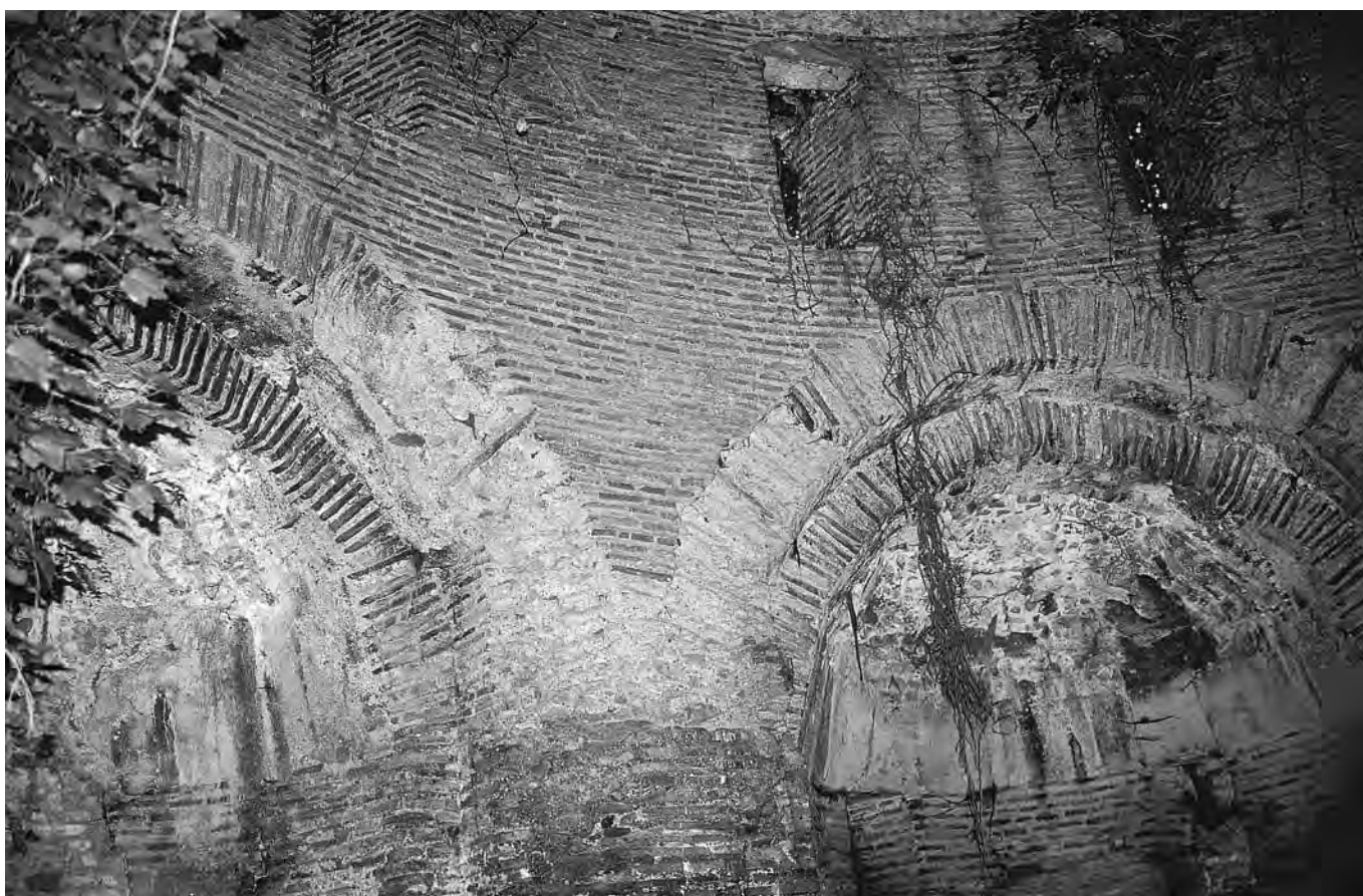
Fig. 329 - Mausoleo esaconco: ghiera con laterizi asportati.
