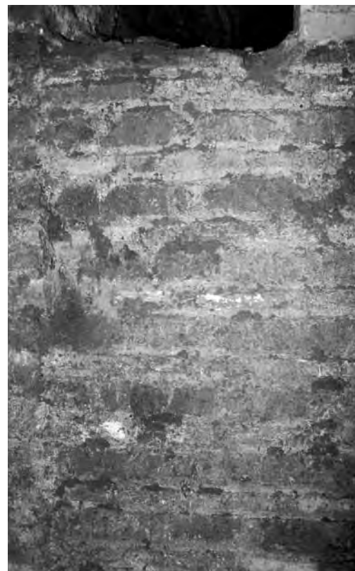
Fig. 202 - Cubicolo Ak: particolare dell'opera listata di tamponamento del lato ovest.
