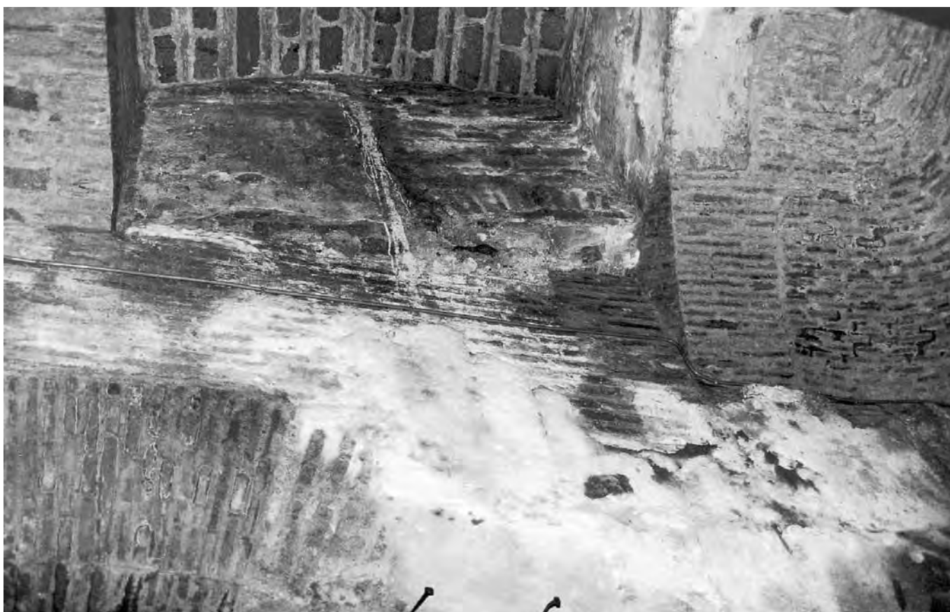
Fig. 209 - Spelunca magna , murature di rivestimento del pozzo preesistente in prossimità di Ag.
