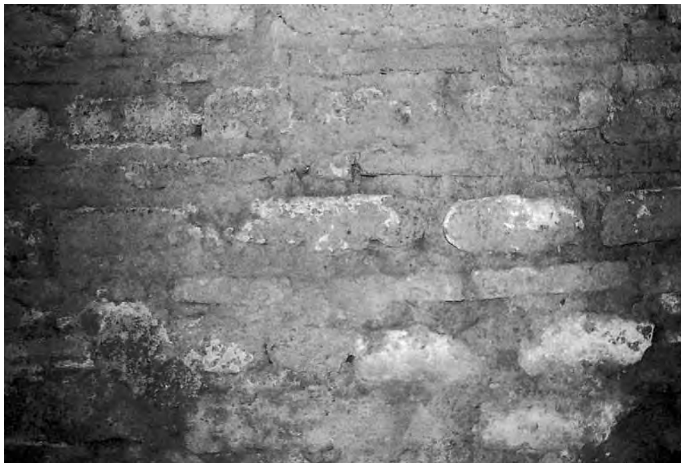
Fig. 20 - Murature in opera listata di rivestimento del settore superiore della scala G.
