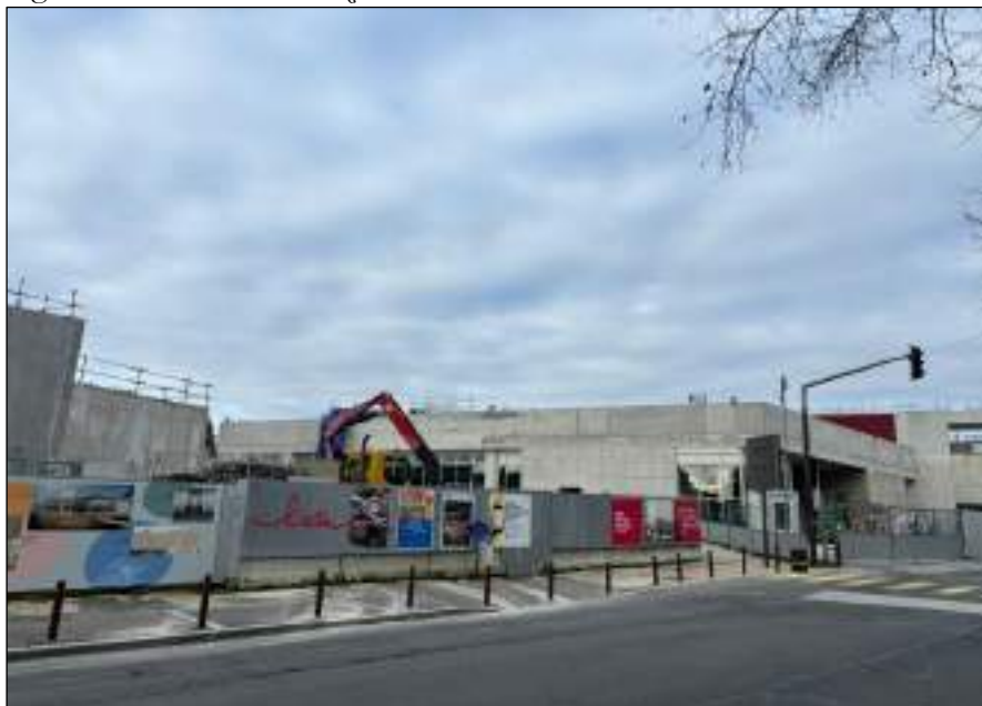
Fig. 1 – Il cantiere della stazione RER di Cachan
