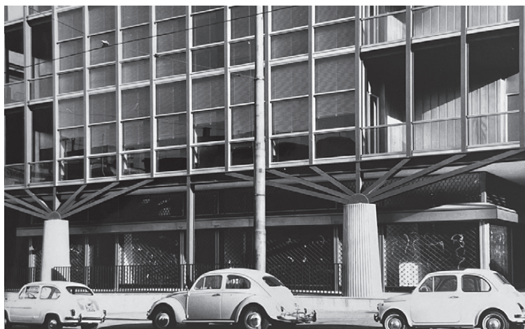
Figg. 15-17 - Viste di dettaglio. Visibile il nodo tra la struttura metallica e il pilastro in cemento armato con la particolare soluzione del capitello a ventaglio (AI, faldone 1116)
