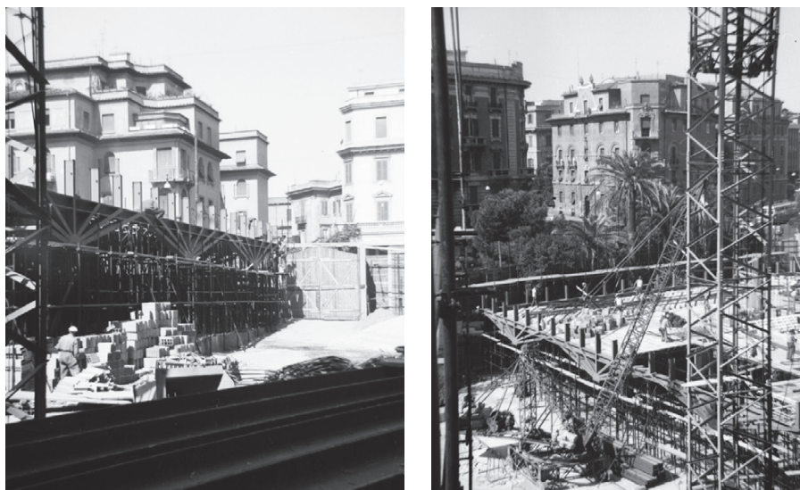
Figg. 9, 10 - Viste del cantiere (AR, FC_03_EdificioPiazzaSassari_n.21 e n.29 su concessione dell'Università degli Studi di Padova - Ufficio Gestione Documentale)
