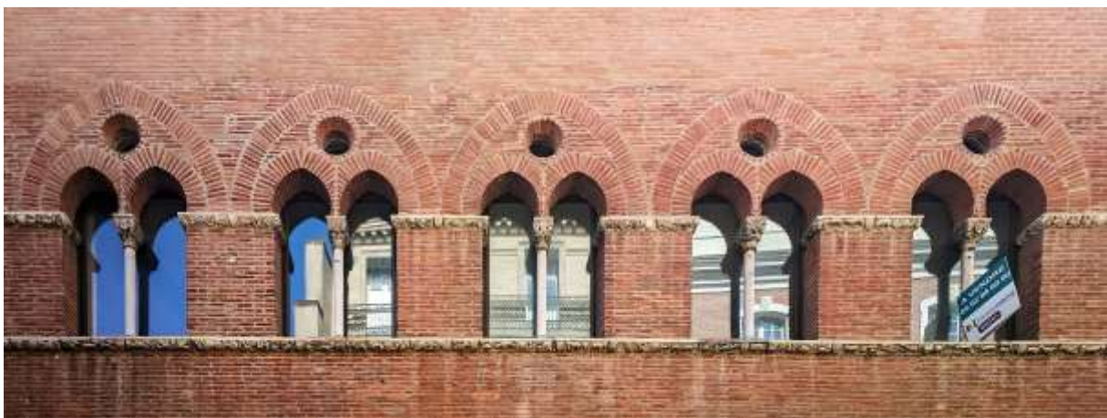
Vue des baies géminées.
