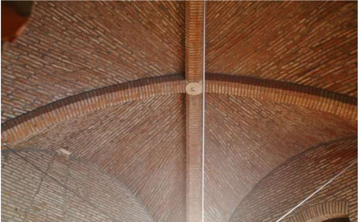
Vue de la voûte du rez-de-chaussée de l'hôtel Maurand.
