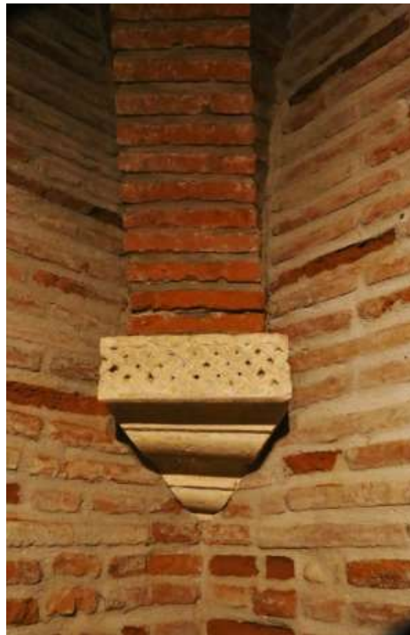
Détail d'un culot sculpté de la voûte du rez-de-chaussée de l'hôtel Maurand.
