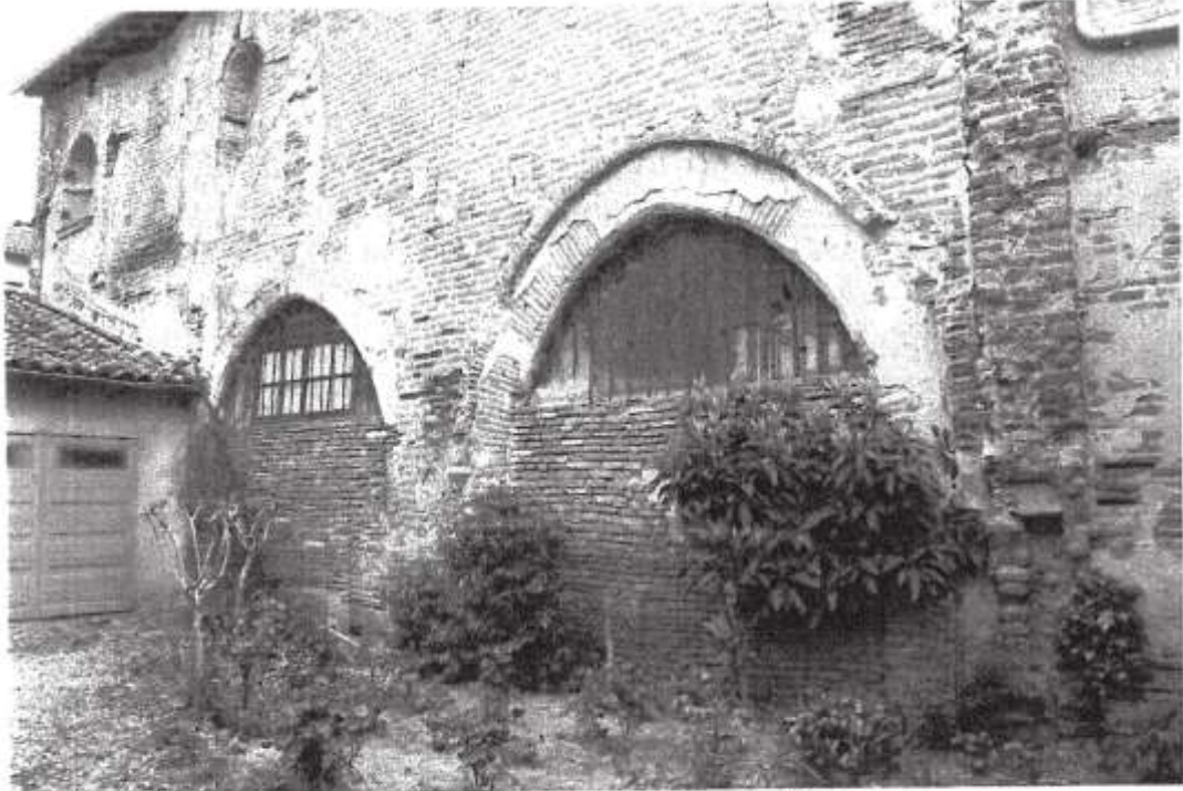
Fig. 28. Moissac, grande demeure en forme d'hôtel 3-5, rue des Maréchaux : façade sur cour du corps A, évidée de grandes arcades. À l'extrémité gauche, arrachement de l'étage du corps B : cheminée encadrée par deux placards. (cl. P. Garrigou Grandchamp)
