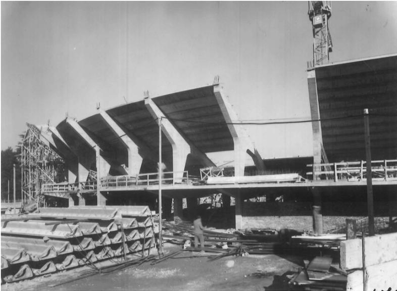
Fig. 10: Le gradinate in costruzione, in basso si vedono i sottogradi pronti per la messa in opera
