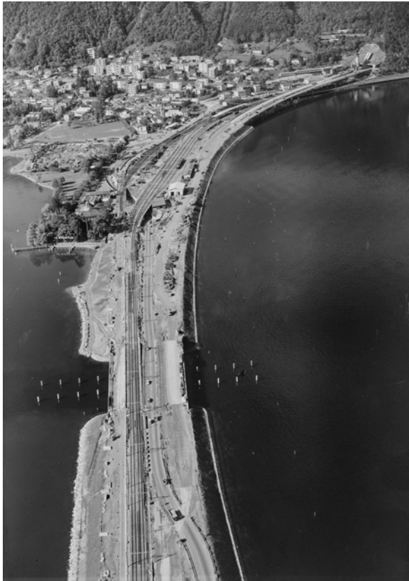
La costruzione del tratto di autostrada sul Ponte-diga di Melide, 1966 (ETH-Bibliothek Zürich, Bildarchiv, Comet Photo AG (Zürich), Com_F66-08862-A / CC BY-SA 4.0)
