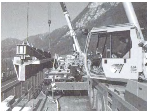
Studio d'ingegneria Grignoli Muttoni, rifacimento del viadotto delle Cantine, rimozione dell'impalcato esistente, dettaglio delle travi esterne, schema dell'attrezzatura di cantiere, 2002 (da "Archi", 2006, n. 2, p. 58)
