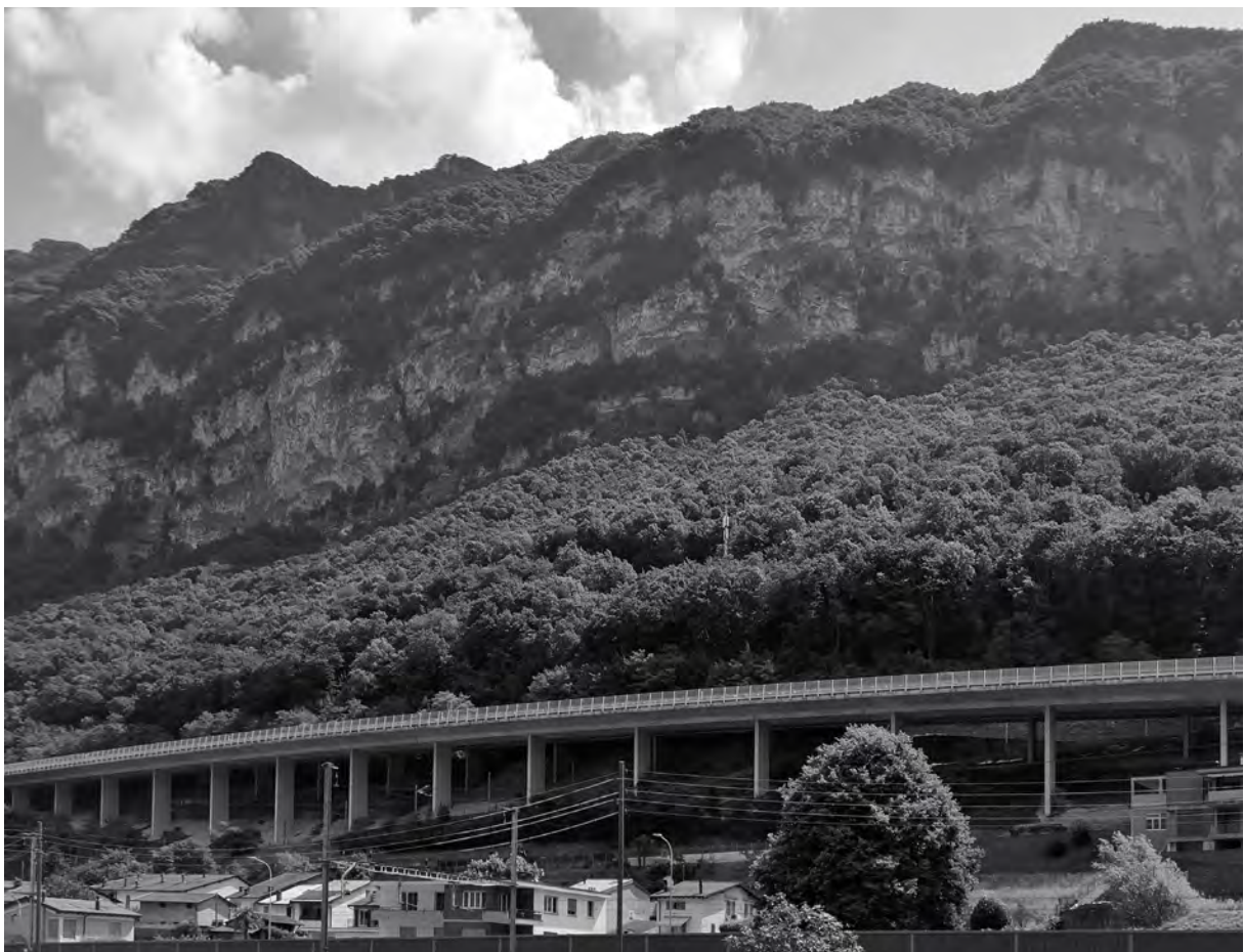
Vista del Viadotto delle Cantine da Capolago dopo l'intervento di risanamento (foto di Nicola Navone, 2020)
