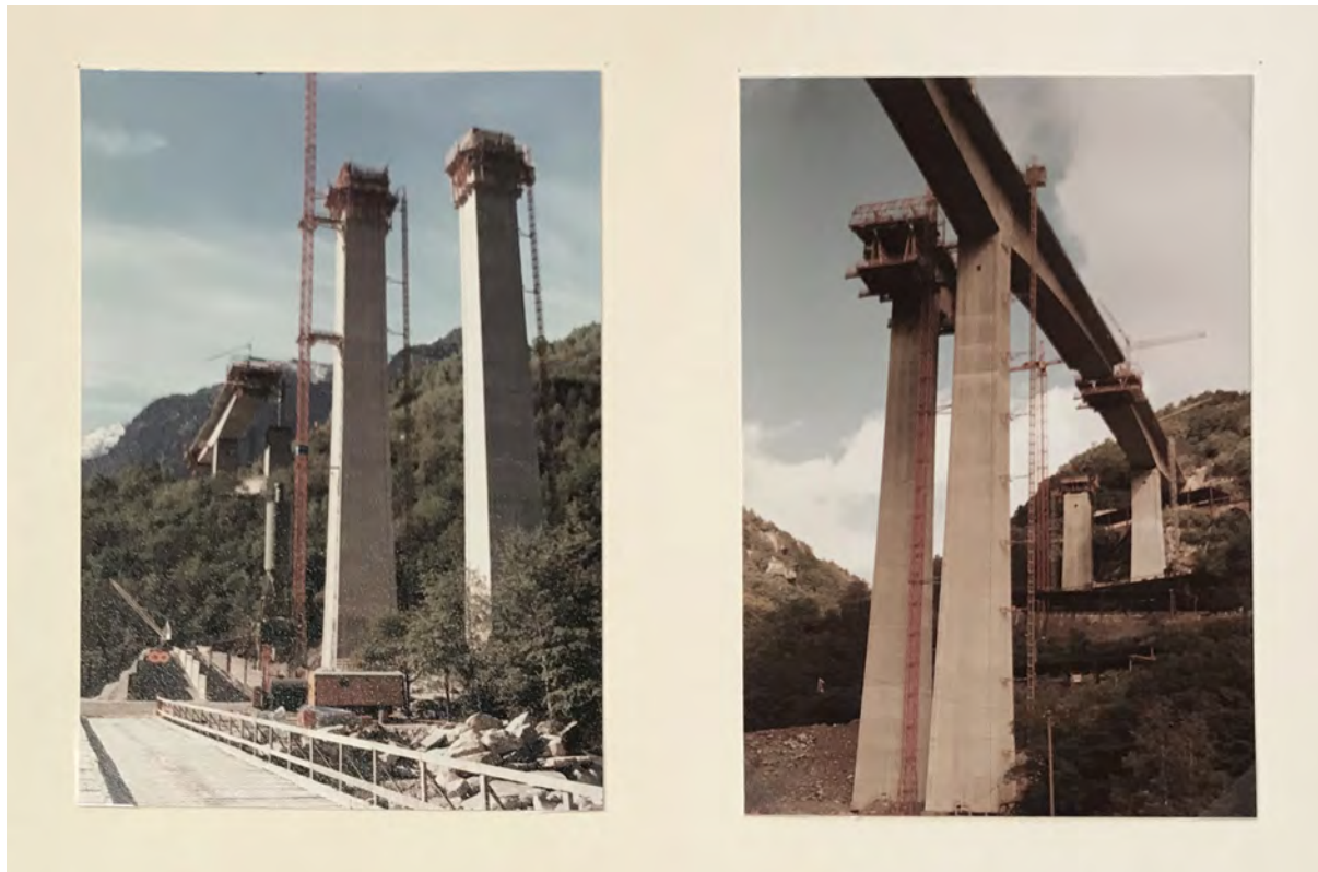
Fotografie del cantiere del Viadotto della Biaschina, dagli album di Renato Colombi, 1983 (AdM, Fondo Renato Colombi)
