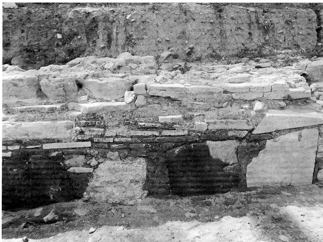
fig. 21 – Particolare del paramento murario del muro del portico.
