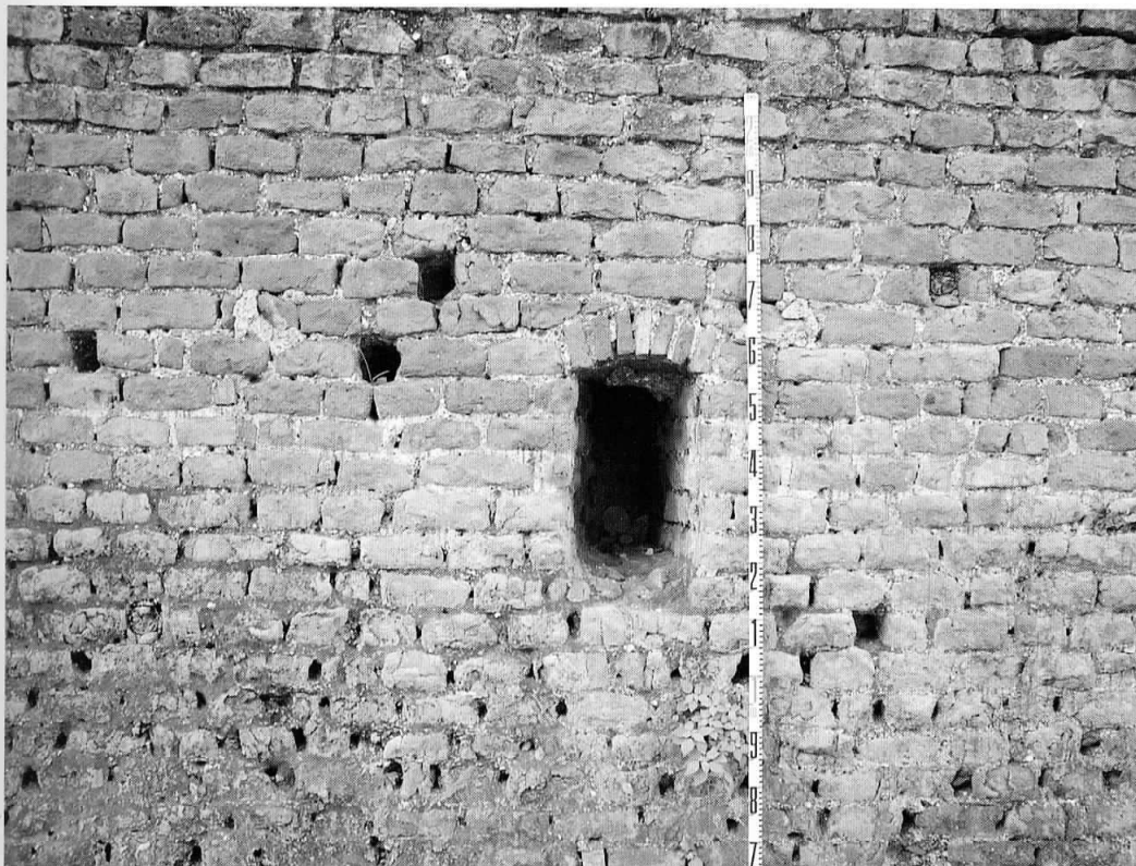
fig. 26 – Paramento a blocchetti lapidei della Rocca Savelli (Roma).
