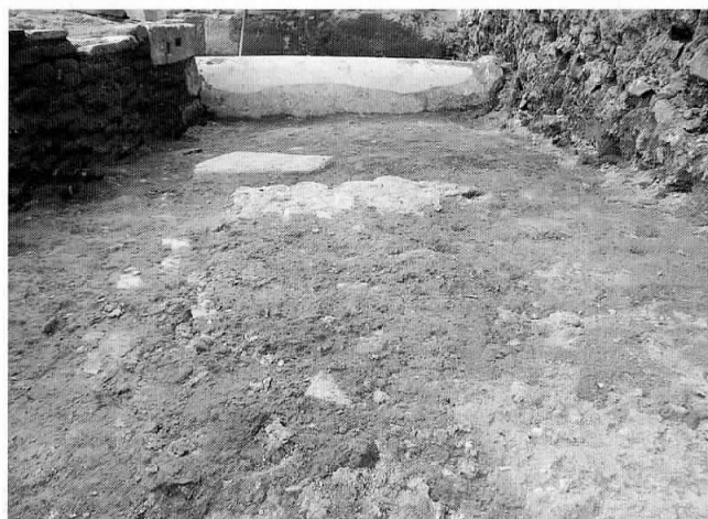
fig. 12 – Depositi di materiale da attività di cantiere.
