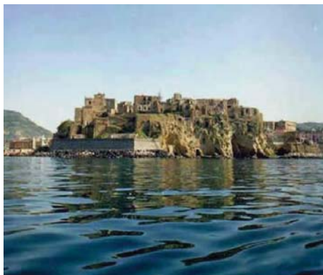
Fig. 1 – Rione Terra-Pozzuoli, vista dal mare. Fonte: www.julienews.it .
