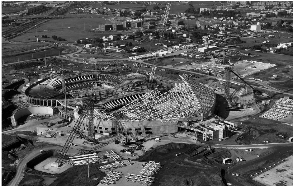
Fig. 7. Il cantiere della Città dello Sport durante le fasi di assemblaggio della struttura in acciaio. A piè d'opera i conchi della copertura
