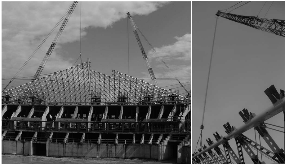
Fig. 6. Alcune fasi di assemblaggio dei concci della copertura del palanuto
