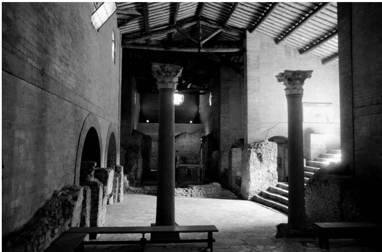
Fig. 346 – Complesso monumentale di S. Alessandro al VII miglio della via Nomentana. L'atrio A e l'aula M visti dalla basilica B.
