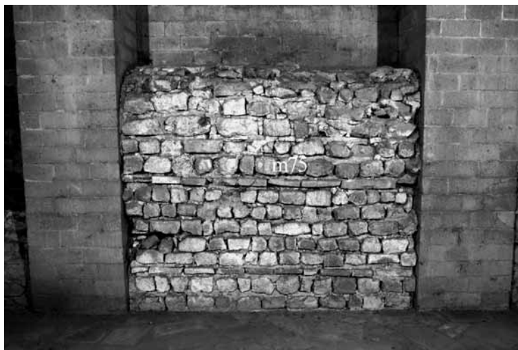
Fig. 331 – Complesso monumentale di S. Alessandro al VII miglio della via Nomentana. Muro di delimitazione occidentale della basilica B.
