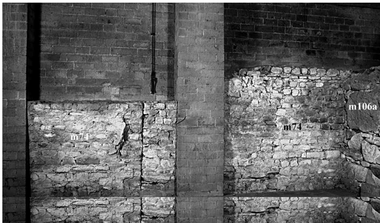
Fig. 329 - Complesso monumentale di S. Alessandro al VII miglio della via Nomentana. Muro di delimitazione occidentale della basilica B.
