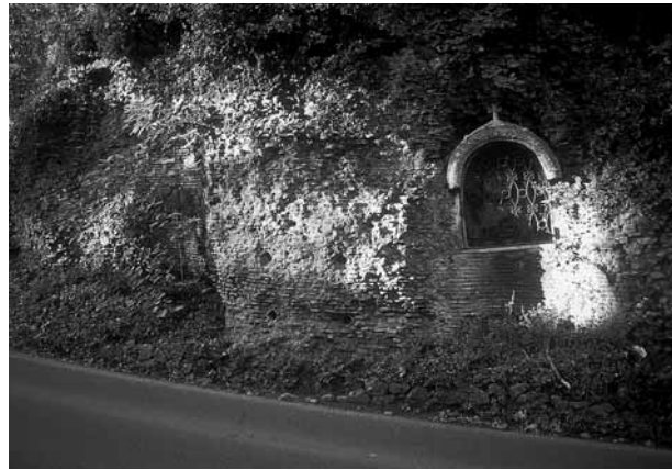
Fig. 436 – Sostruzioni arcuate della via Nomentana all'altezza del km 20,500.
