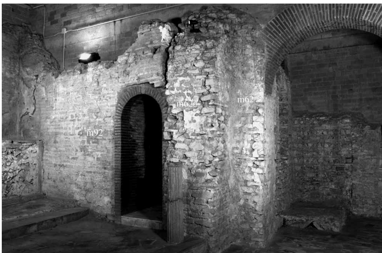
Fig. 315 – Complesso monumentale di S. Alessandro al VII miglio della via Nomentana. Lato ovest del settore meridionale dell'aula M (M1), con imbocco al vano V3.
