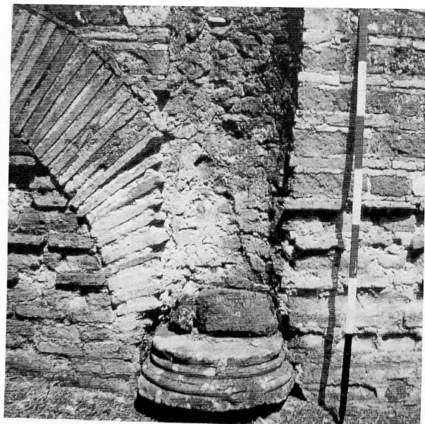
Fig. 4. Base e impronta di una colonna inglobata nell'abside della chiesa di S. Stefano sulla via Latina (da SORRENTI 1996).
