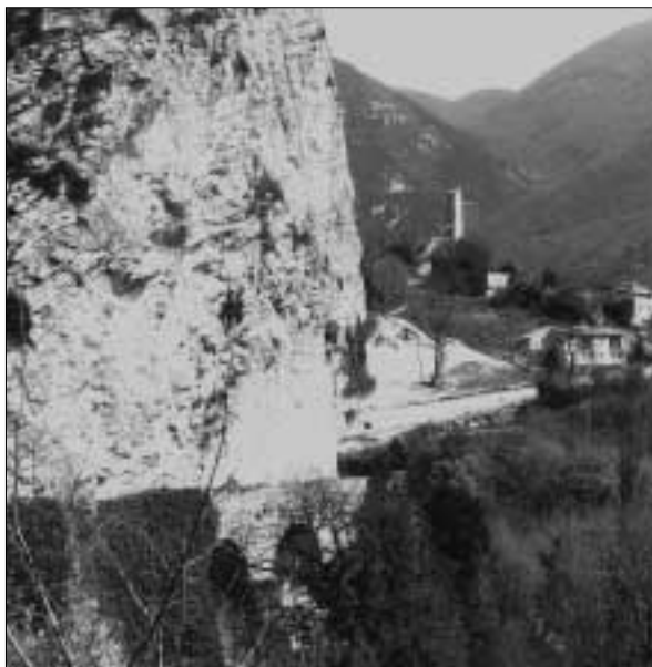
1. TRIPONZO - Loc. «Lo Scoppio». Veduta d'insieme della rupe tagliata e dei muri di sostruzione in funzione del passaggio della via antica (U 1).
