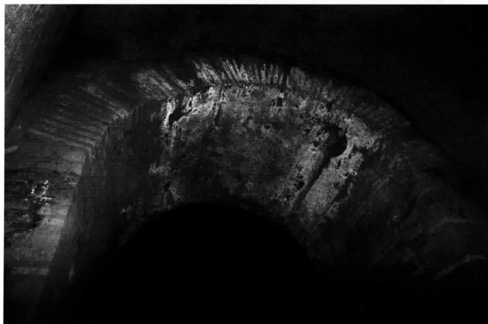
FIG. 8 - Struttura ad arco di rinforzo nell'arenario.
