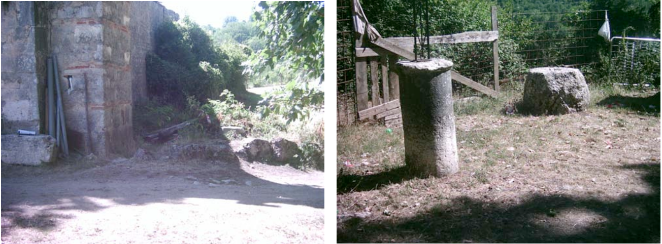
Figure 57-58. Resti di opera poligonale e di materiale di spoglio di edifici precedenti.
