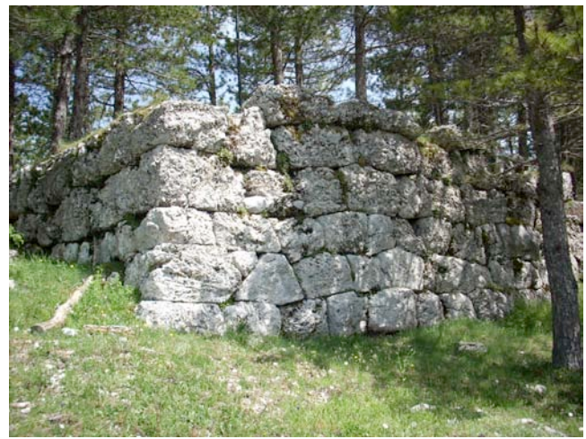
Figure 75-76. A sinistra, il passo dell'Aquilente come si presenta oggi; a destra, particolare del grande muro in opera poligonale.
