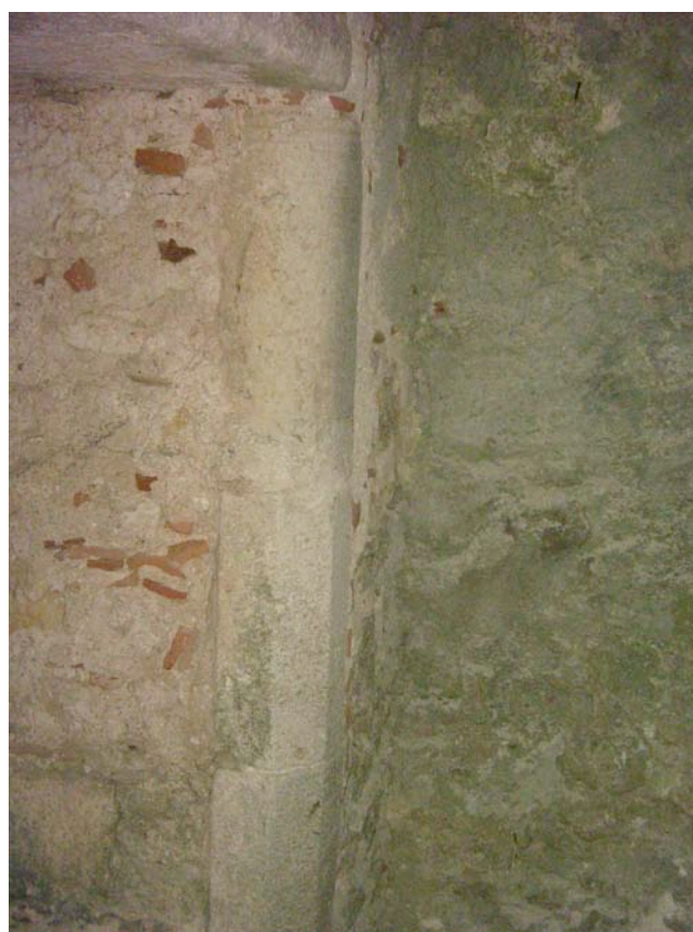
Figure 54-55. Particolare dell'opera poligonale presente tra la parte finale della navata sinistra e l'abside. All'interno della chiesa sono evidenti i segni di lavori successivi all'impianto originale: a destra è visibile un pilastro inglobato nella struttura muraria del campanile.
