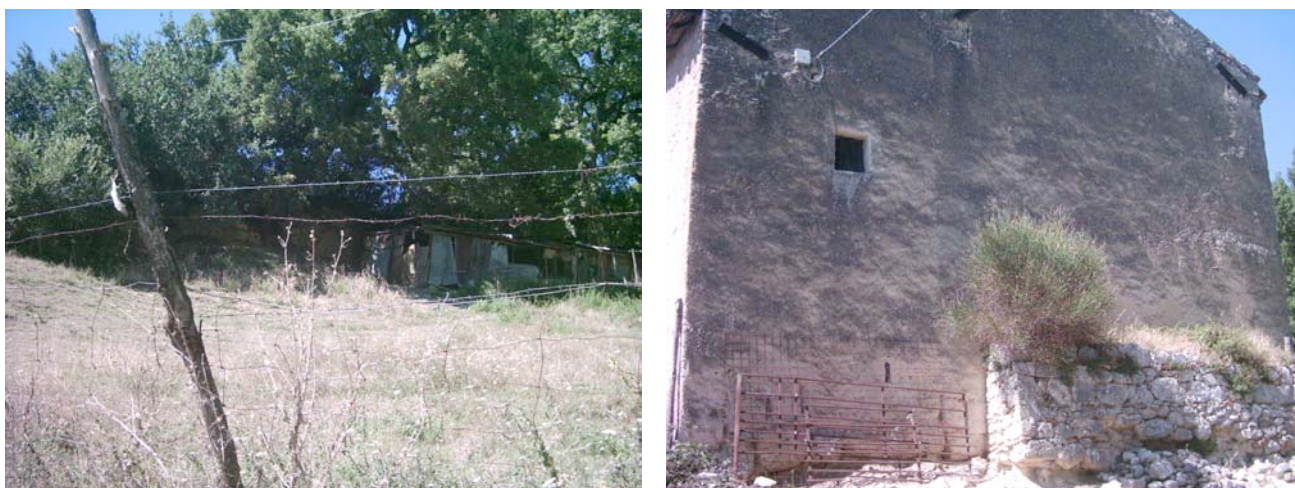
Figure 60-61. Resti dell'imponente muro poligonale a sorreggere il terrazzamento su cui sorge la chiesa (a sinistra): al muro si addossano stalle per animali. Resti murari riconducibili ad altri ambienti addossati alla chiesa stessa.
