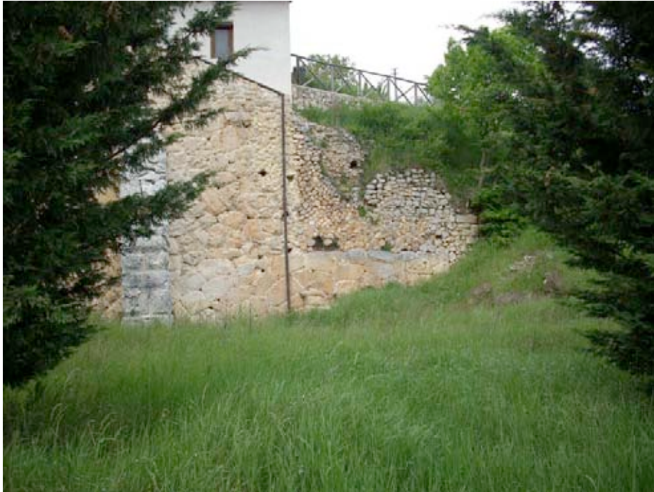
Figura 37. Particolare della chiesa della Madonna delle Grazie, in cui sono ben visibili l'opera poligonale e l'opera incerta.
