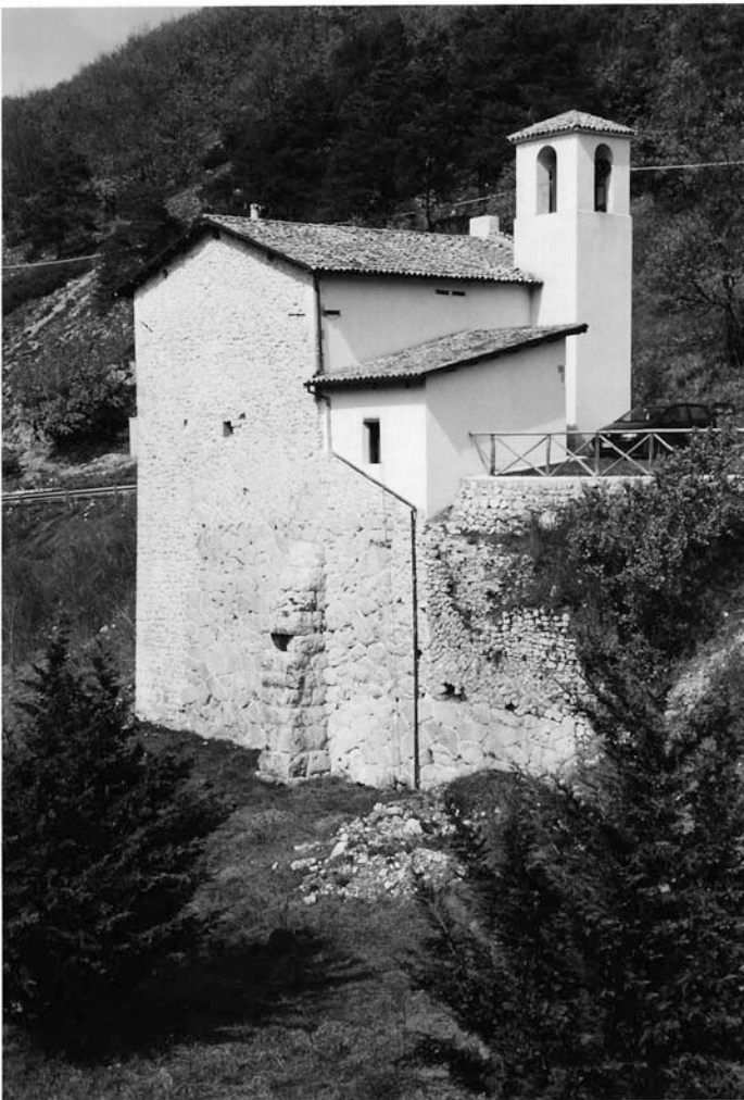
Figura 1. Chiesa della Madonna delle Grazie presso Cliviano. Sono visibili gli elementi in muratura antica su cui è stata costruita la chiesa.
