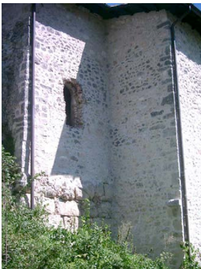
Figure 54-55. Particolare dell'opera poligonale presente tra la parte finale della navata sinistra e l'abside. All'interno della chiesa sono evidenti i segni di lavori successivi all'impianto originale: a destra è visibile un pilastro inglobato nella struttura muraria del campanile.
