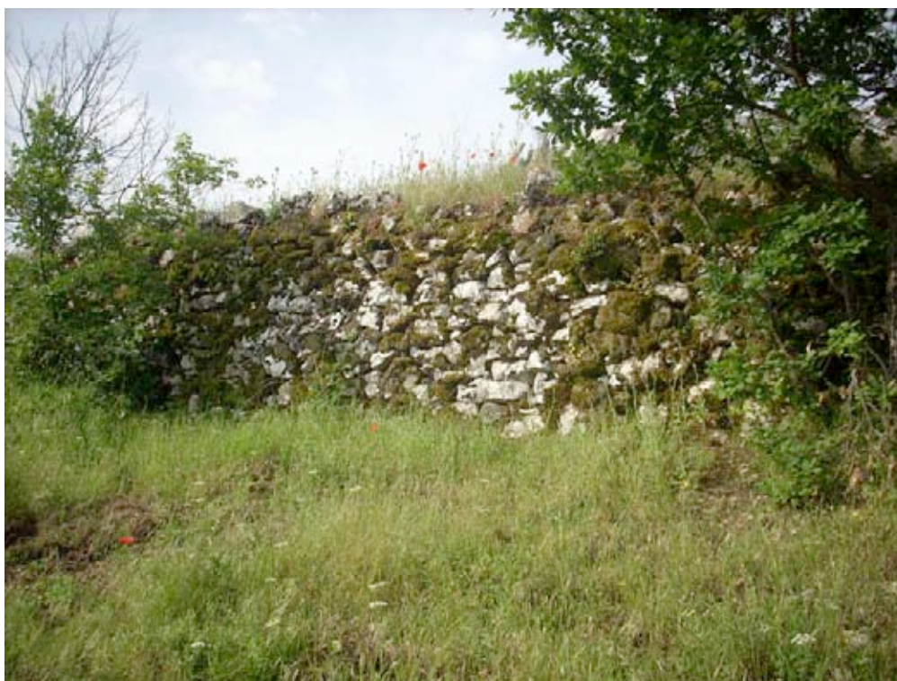
Figura 64. Resti di un muro sul sito in cui sorgeva la vecchia chiesa di San Pietro presso Radicaro
