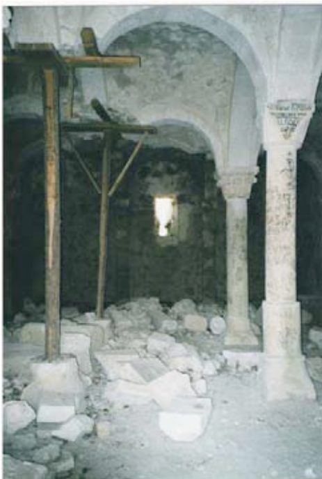
Figura 12-13. San Giovanni in leopardis . È visibile lo stato attuale della cripta dopo le devastazioni del 1985. Come si vede, le colonne sono state spezzate e sostituite con pali di legno. All’esterno della cripta si nota la presenza di un recinto di muro in opera poligonale.
