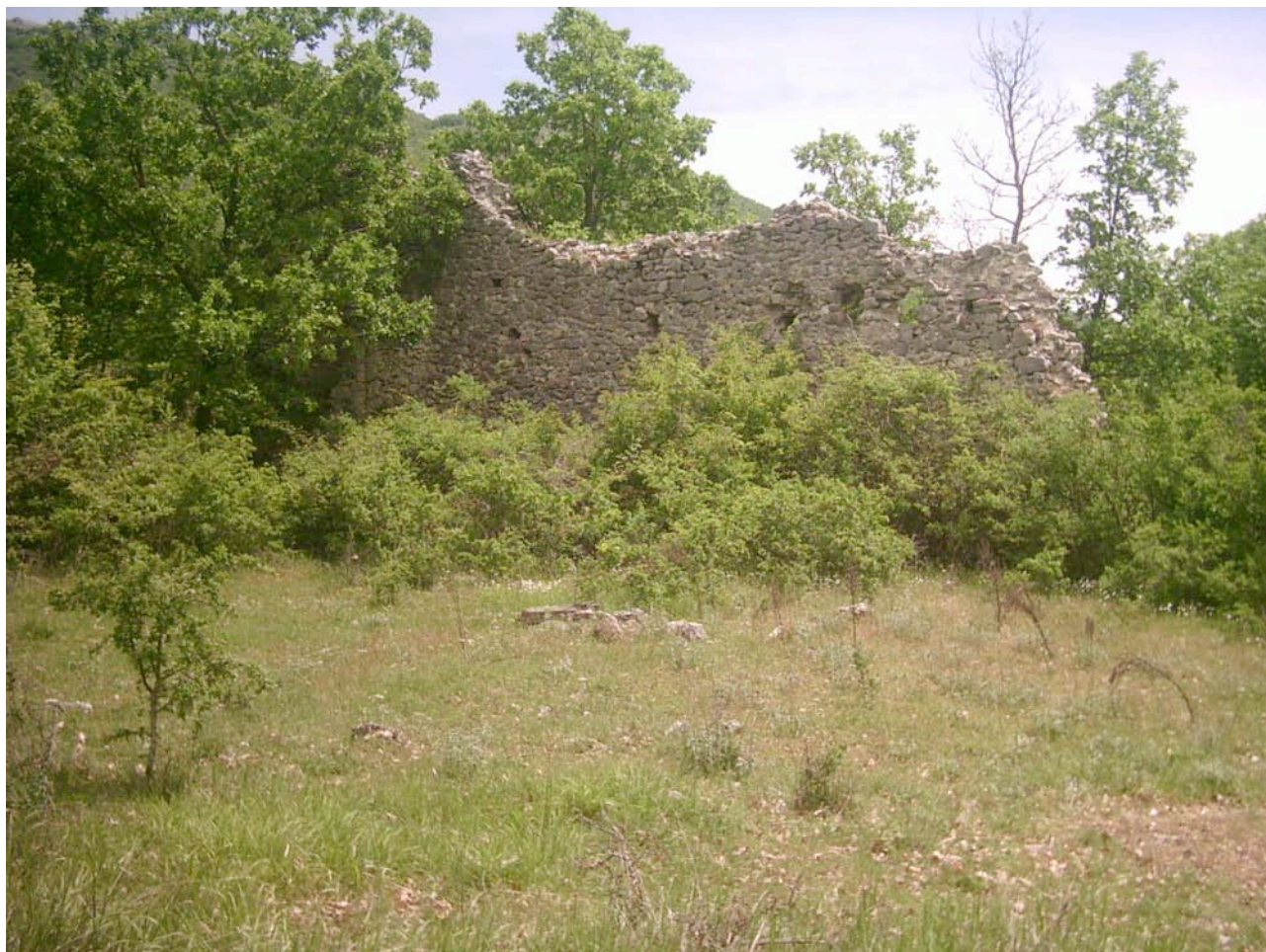
Figura 10. Località Colle San Giovanni, Petrigliano (Pescorocchiano). Cella Sancti Benedicti . Resti dei muri perimetrali. Si può vedere come sulla sommità del colle, vicino ai resti della chiesa e delle sue pertinenze, sia stato spianato il terreno, dal quale emergono resti di materiale da costruzione.
