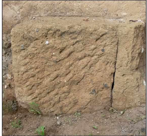
**Fig. 112** – *Castrum Inui*: particolare delle tracce di lavorazione
