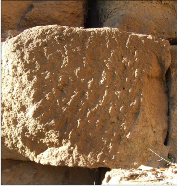
**Fig. 111** – Mura urbane: particolare delle tracce di lavorazione
