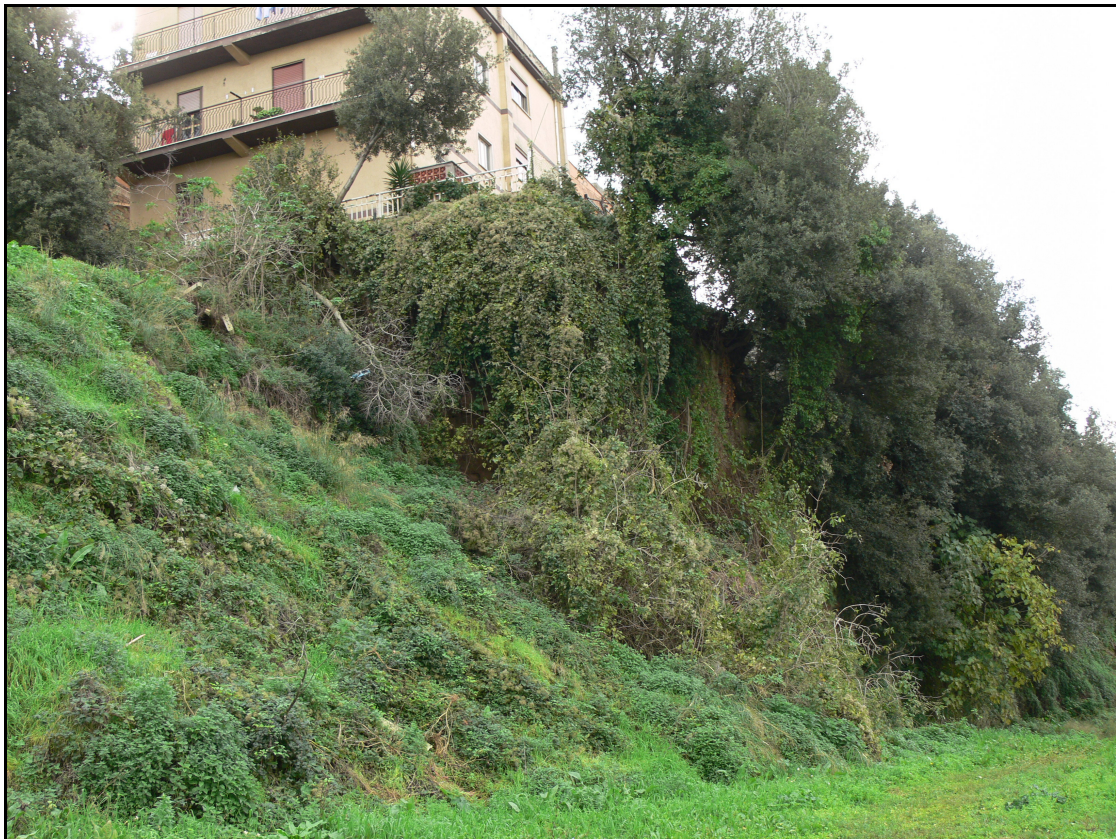
Fig. 49 – Angolo nordoccidentale della fortificazione dell' Acropoli
