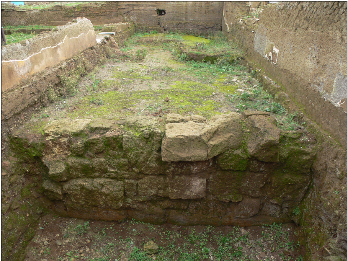
Fig. 60 - Castrum Inui , Tratto 2.2: facciavista nord-ovest
