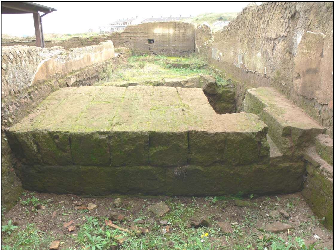
Fig. 58 - Castrum Inui , Tratto 2.1: facciavista nord-ovest
