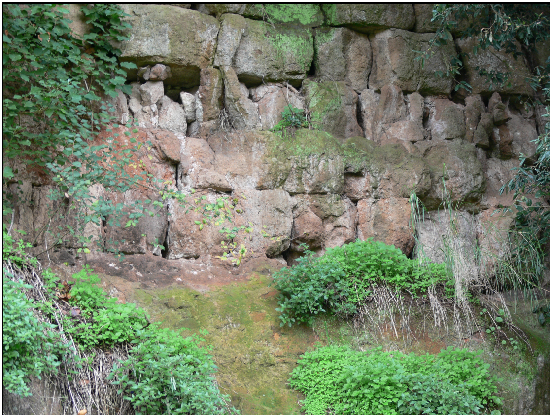
Fig. 50 – Mura urbane, Tratto 8: particolare dei filari originari
