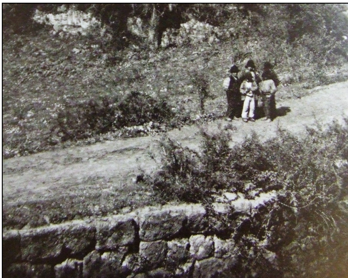
Fig. 56 – Mura urbane, Tratto 12: particolare del viadotto (da Morselli-Tortorici 1982)
