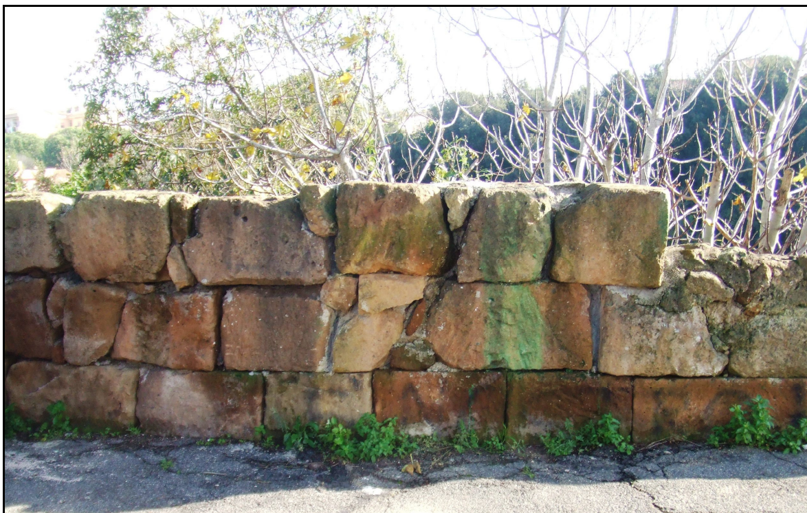
Fig. 44 – Mura urbane, Tratto 3: lato interno
