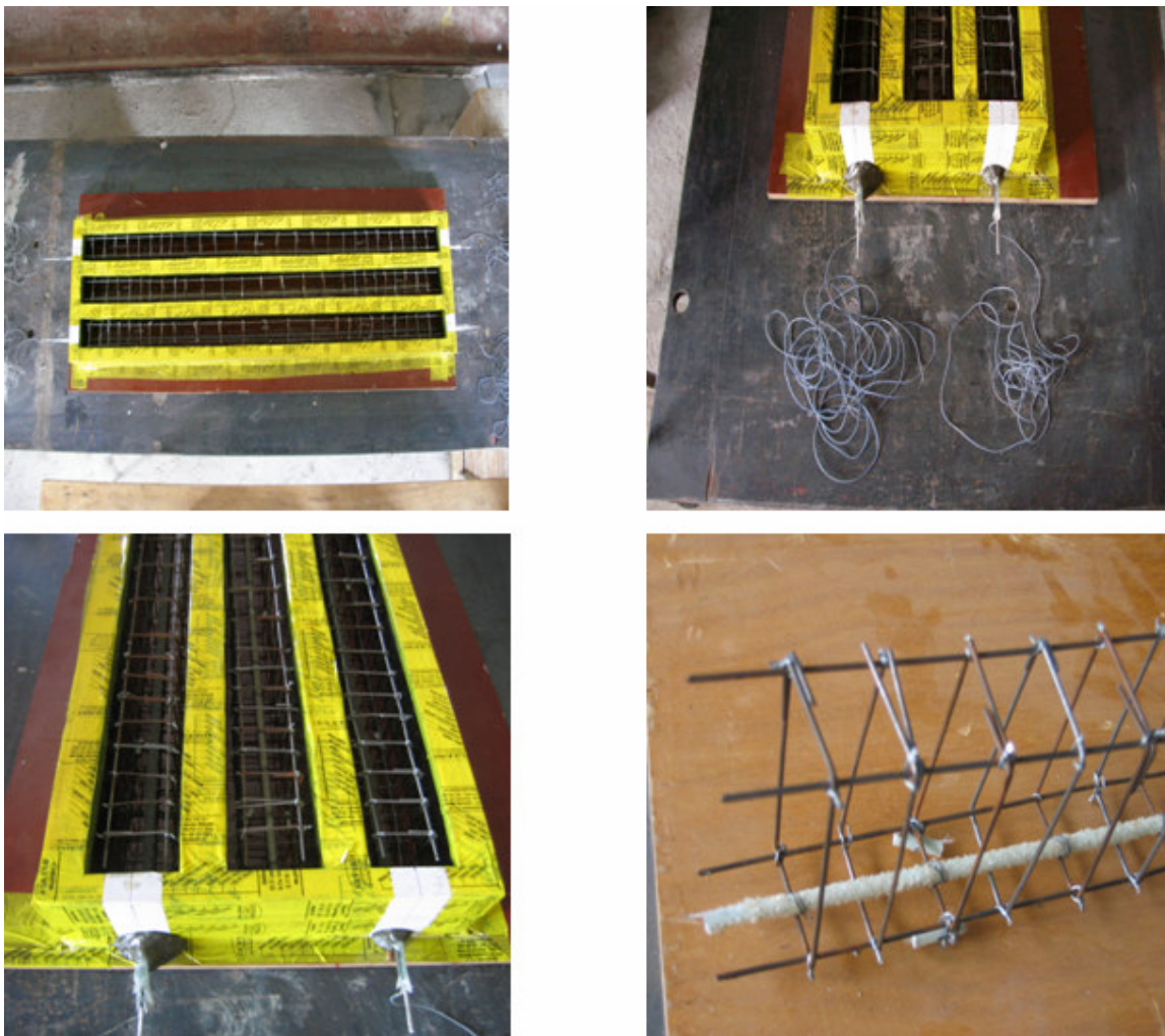
Fig 7.4: Inserimento dei tondini nell'armatura
