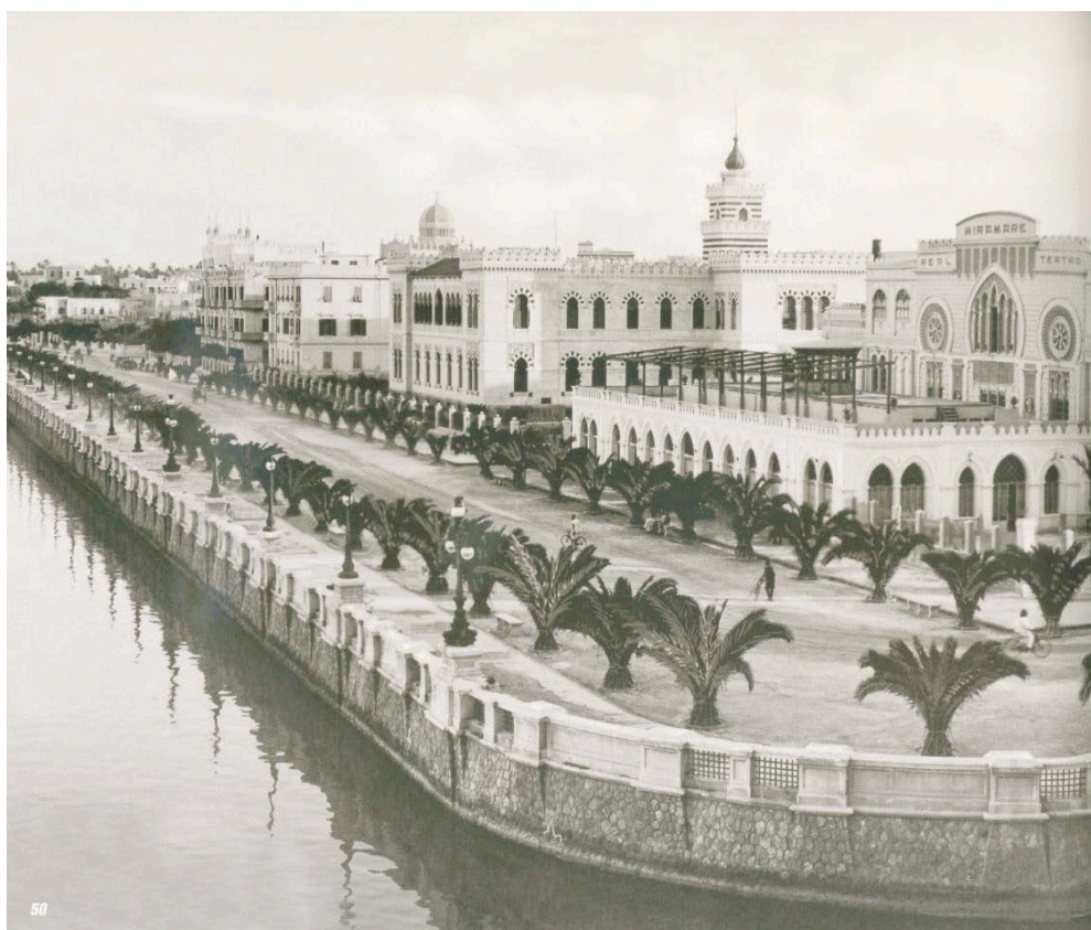
FIGURA 1. TEATRO MIRAMARE - VISTA DAL MARE*
