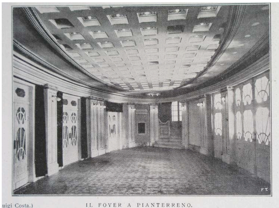
FIGURA 4. TEATRO MIRAMARE - FOYER [ITC luglio 1928, p. 149]
