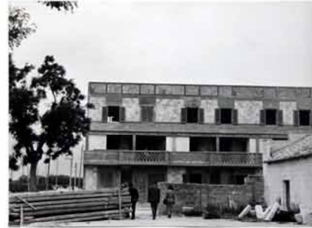
fig. 42: foto di cantiere delle case a schiera di tipo DE
