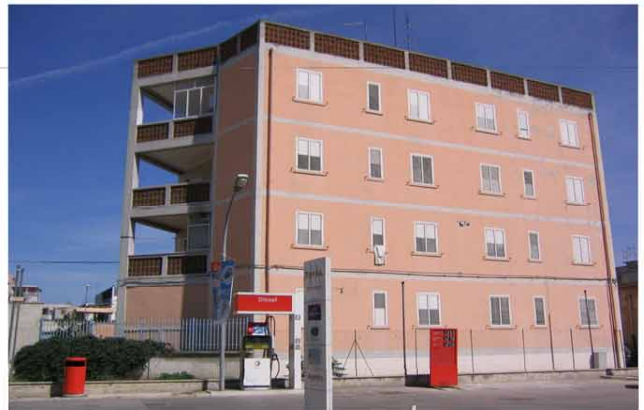
Fig. 84: vista del prospetto completo dell'edificio su via Circonvallazione
