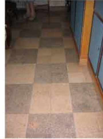
Fig. 42: pavimento di marmette granigliate di una villa A: schema di posa da prendere come riferimento per le camere da letto
