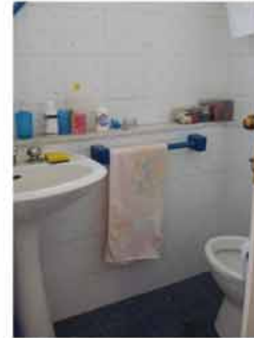
Fig. 29: rivestimenti e sanitari sostituiti
