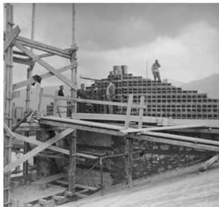
figg. 21- 22- 23: fotografie di cantiere (Accademia Nazionale di San Luca)
