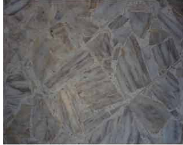
Fig. 40: pavimento interno sostituito
