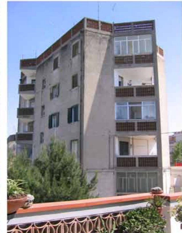
Fig. 78: vista dell'edificio da un ballatoio di una casa a schiera DE
