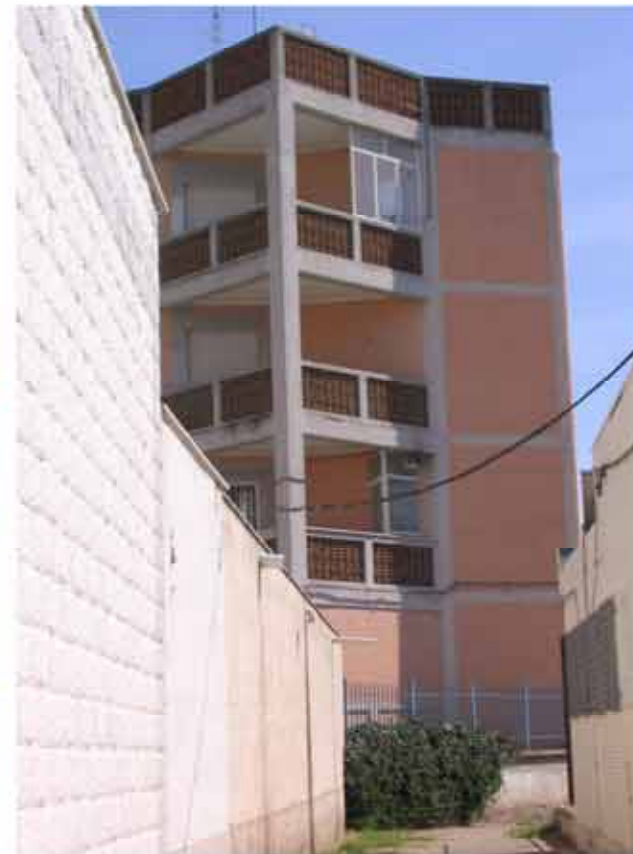
Fig. 80: vista del prospetto laterale dal cortile interno dell'edificio C
