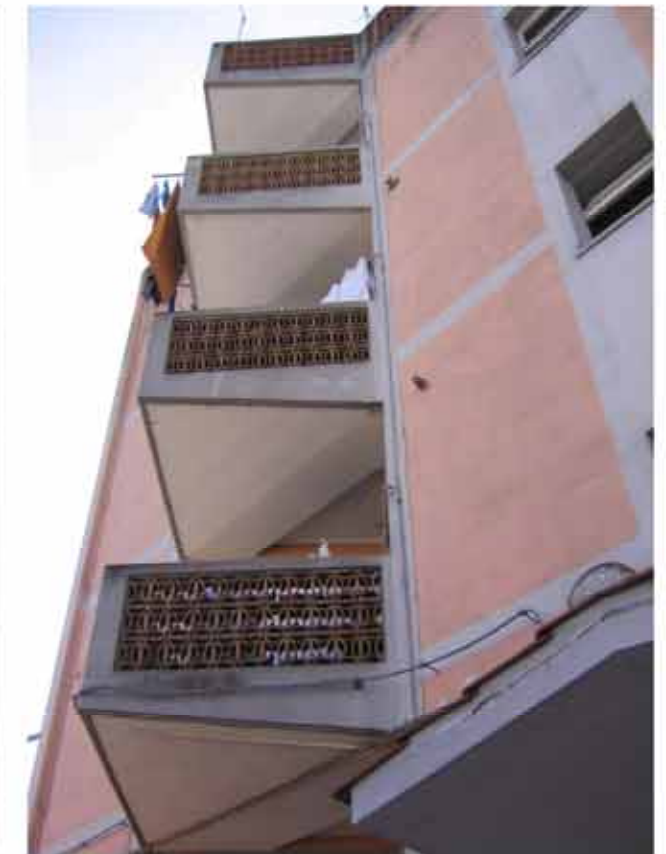
Fig. 82: dettaglio dei terrazzini triangolari del prospetto principale
