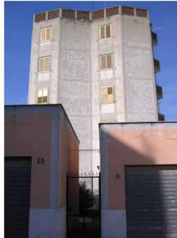
Fig. 73: vista laterale dell'edificio
