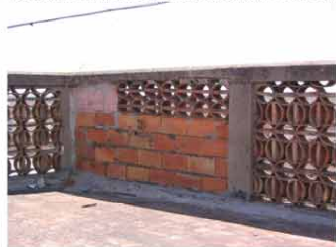
ALCUNI ESEMPI DELLO STATO DI DEGRADO DELLE BALAUSTRE IN ANELLI DI COTTO
