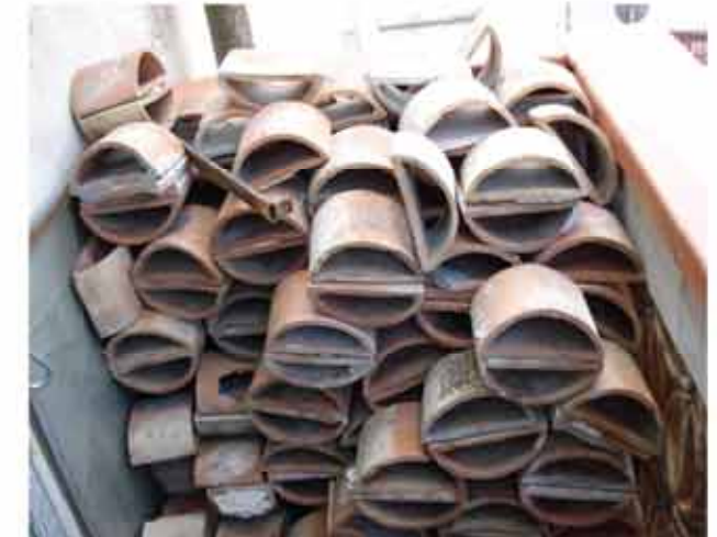
Fig. 34: anelli di cotto originali sostituiti con laterizi di varie forme
