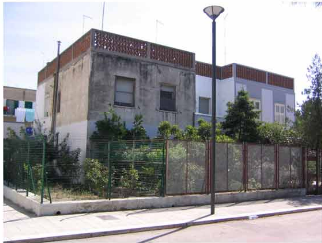
Fig. 90: prospetto principale con giardino di pertinenza che si affaccia sulla pineta centrale
