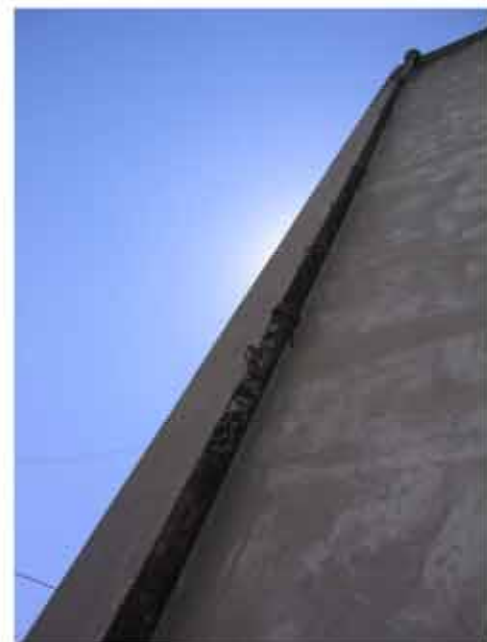
ALCUNI ESEMPI DELLO STATO DI DEGRADO DEI PLUVIALI DELL'EDIFICIO C
