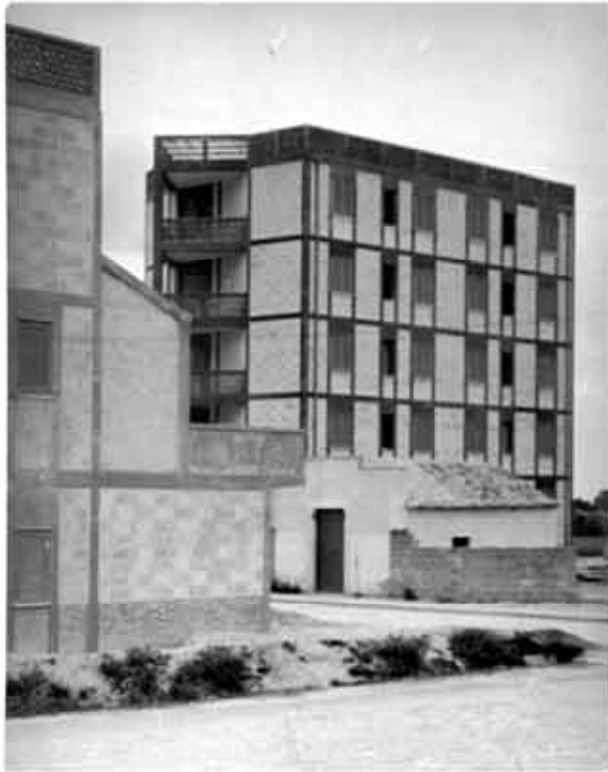
fig.34: vista della casa in linea di tipo C sulla Circonvallazione
