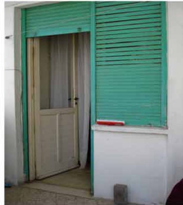
Fig. 22: infisso di tipo 9 con avvolgibile dei terrazzi triangolari del tipo C
