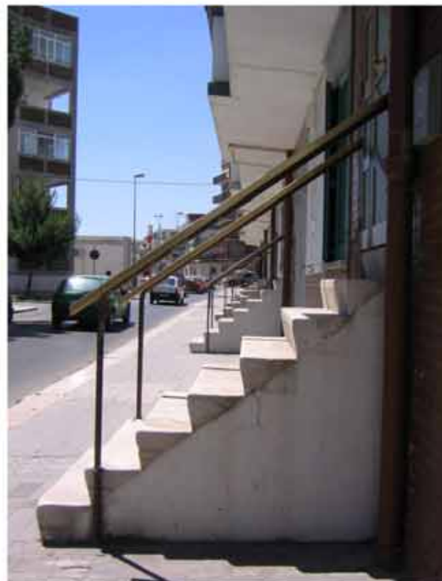
Fig. 69: particolare della scala in pietra di accesso all'alloggio di tipo E
