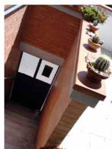
Fig. 35: copertine in cotto sulla balaustra che hanno alterato la sagoma in calcestruzzo
