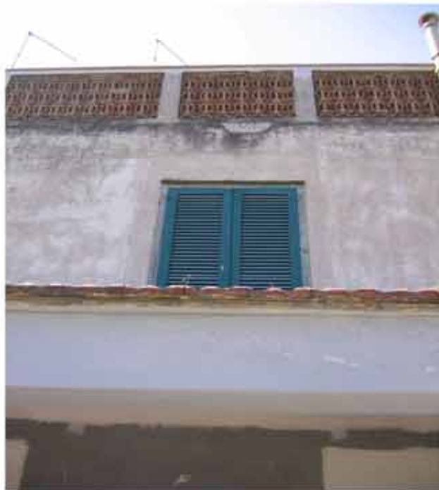
Fig. 20: infisso di tipo 1 dell'alloggio E
