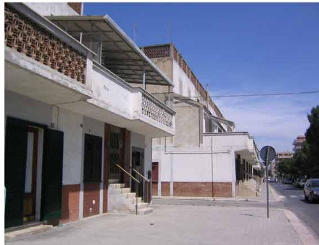
Fig. 67: vista degli ultimi due blocchi di schiere su via Pantanella
