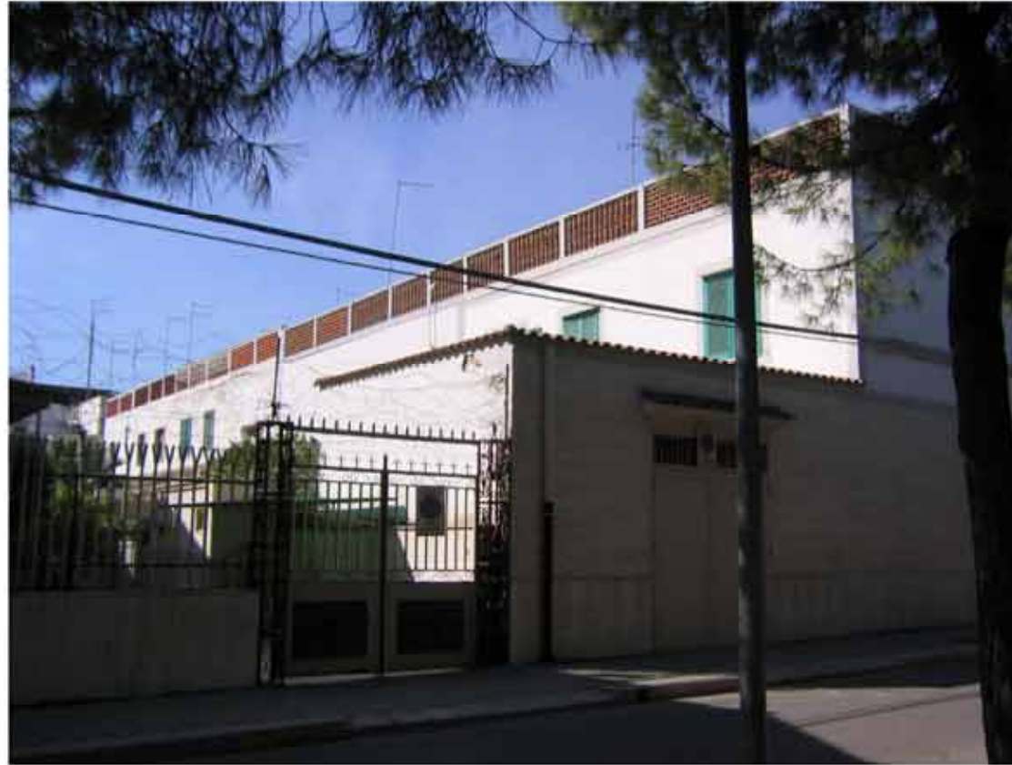
Fig. 85: vista del prospetto laterale su via Calore
