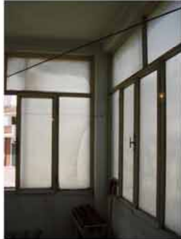
Fig. 39: chiusura con una loggia del terrazzino triangolare
