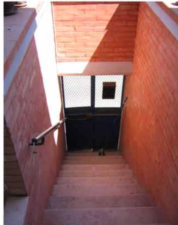
Fig. 6: scala di accesso al tipo E: vista dal terrazzo di accesso all'alloggio dei muri in mattoni di Lucera e del portoncino di chiusura
