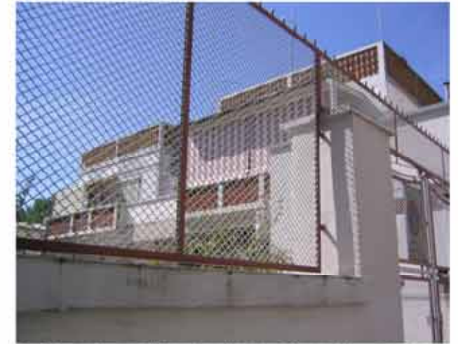
Fig. 11: grata metallica che altera la visione del prospetto laterale delle ville di tipo B
