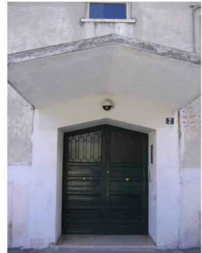
Fig. 15: pensilina di ingresso all'edificio in linea a Cerignola: la pensilina è stata realizzata con una forma semplificata rispetto ai disegni di Ridolfi
