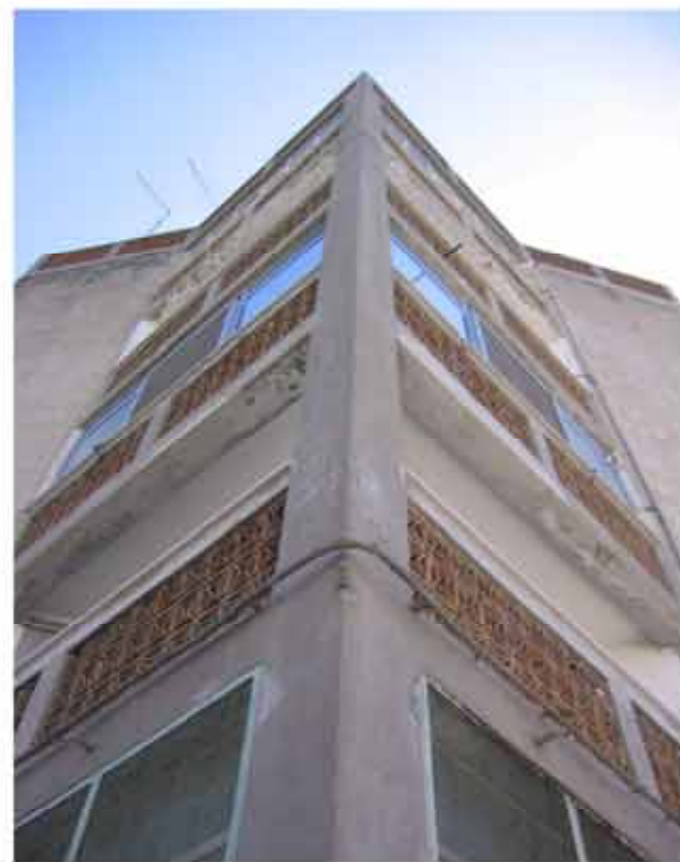
ALCUNI ESEMPI DI MANOMISSIONI E CHIUSURA CON VERANDE IN ALLUMINIO DEI TERRAZZINI TRIANGOLARI DEGLI EDIFICI IN LINEA C E C'
