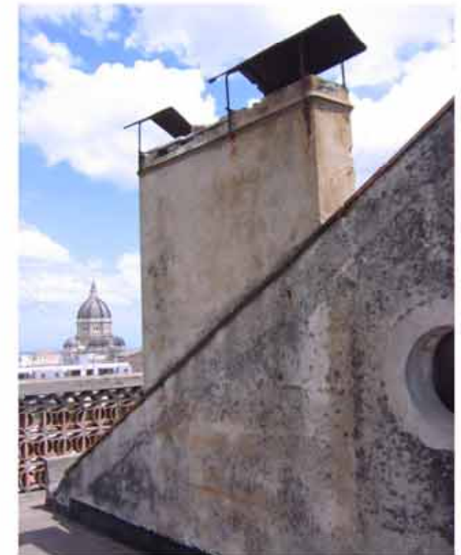
Fig. 4: esterno del torrino scale sul lastrico solare dell'edificio C
