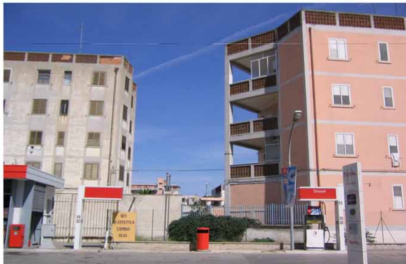
Fig. 83: vista da via Circonvallazione dei due edifici in linea C-C'
