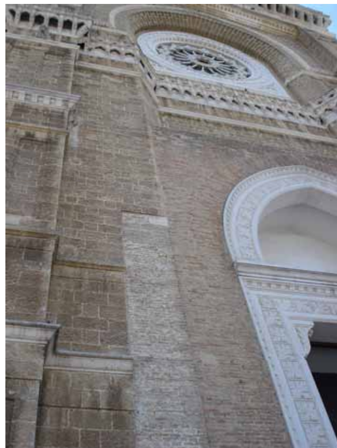
Figura 7: immagine del portale di ingresso in mattoni pressati di Lucera
