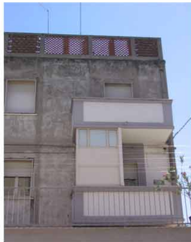
ALCUNI ESEMPI DI MANOMISSIONI E CHIUSURA CON VERANDE IN ALLUMINIO O IN MURATURA DEI TERRAZZINI E DEI TERRAZZI DEGLI EDIFICI IN LINEA DE
