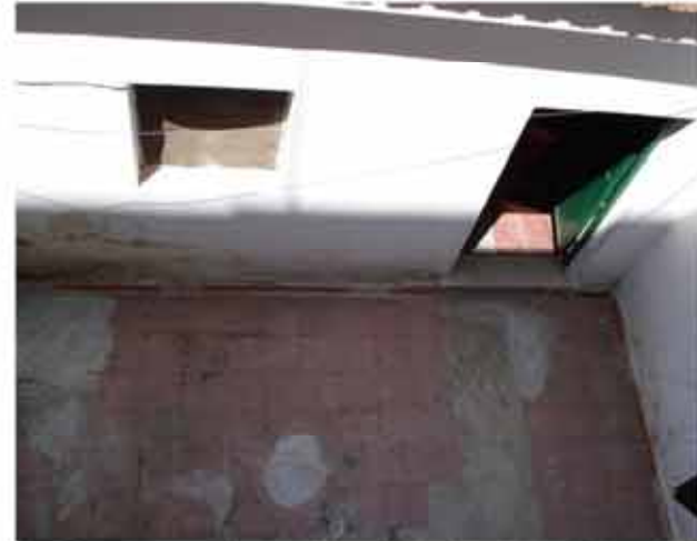
Fig. 27: volume aggiunto al ripostiglio esistente dell'alloggio D che ha in parte ostruito il giardino di pertinenza retrostante
