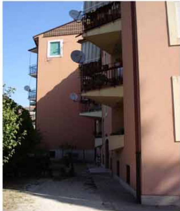
fig. 34: vista del viale di accesso agli edifici
