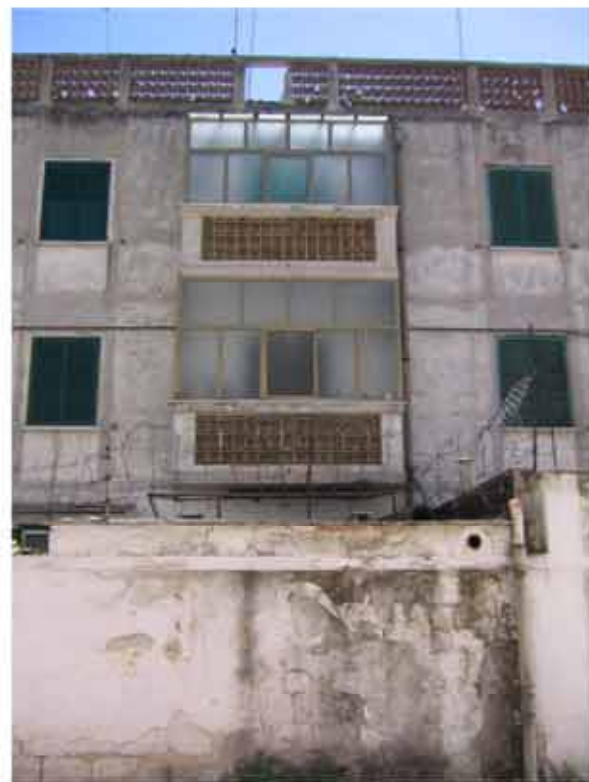
ALCUNI ESEMPI DI MANOMISSIONI E CHIUSURA CON VERANDE IN ALLUMINIO O IN MURATURA DEI TERRAZZINI E DEI TERRAZZI DEGLI EDIFICI IN LINEA DE
