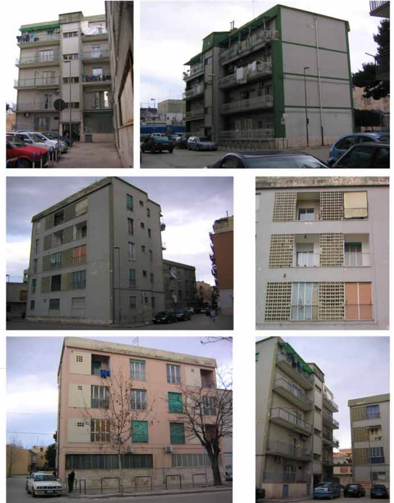
FOTO DELLO STATO ATTUALE DEGLI EDIFICI
