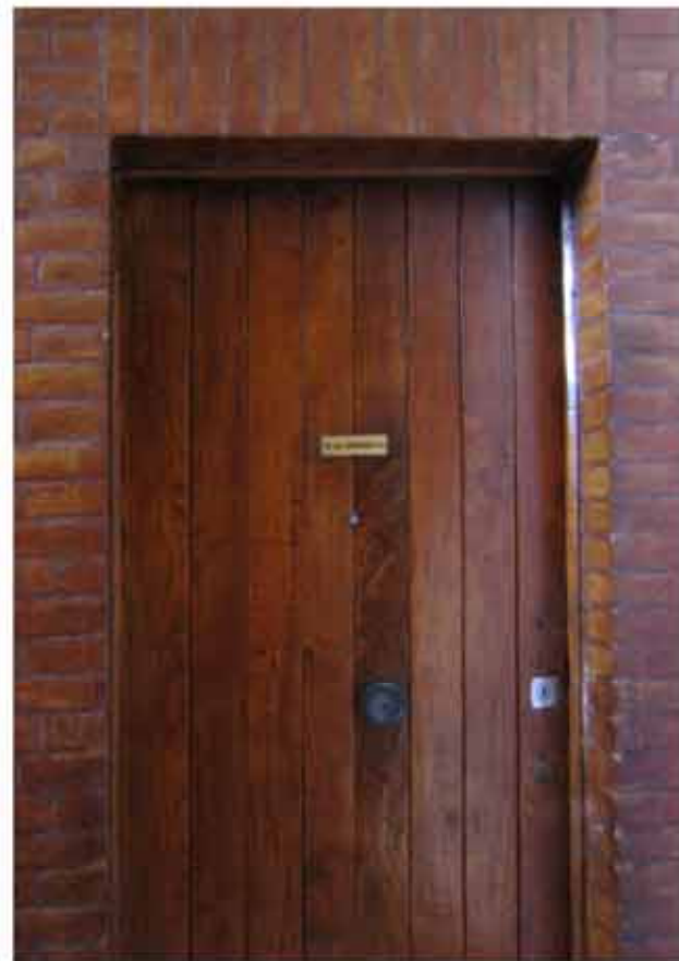
Fig. 24: porta di ingresso agli appartamenti dell'edificio in linea di tipo C
