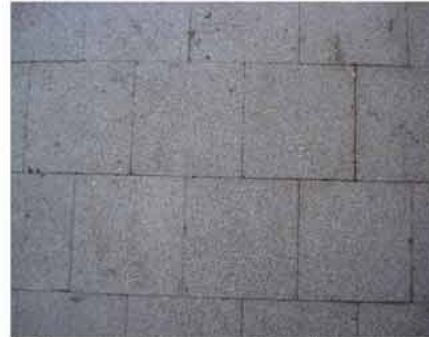
Fig. 28: marmette di cemento granigliato esistenti sul terrazzo
