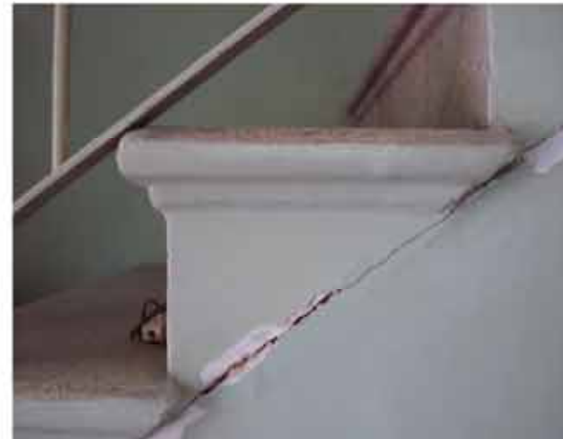
Fig. 31: particolare della scala in cemento granigliato
