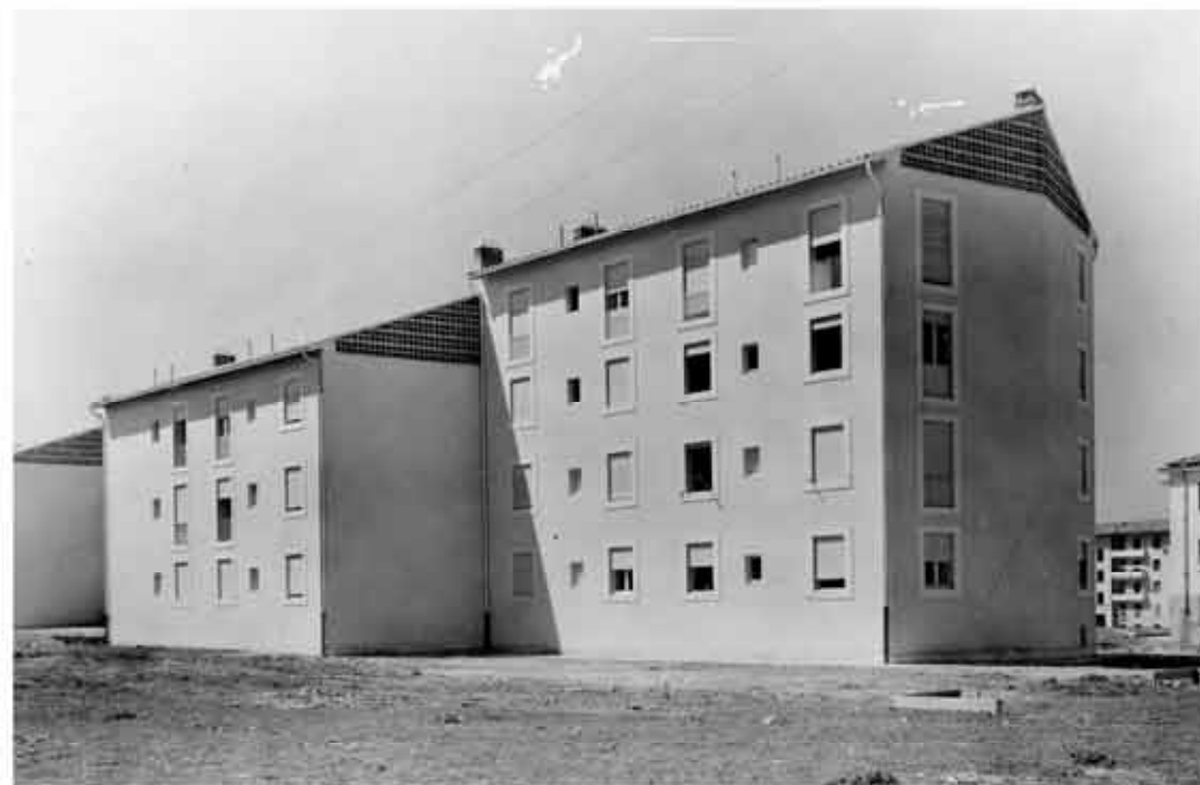
Fig.27: vista dal retro degli edifici
