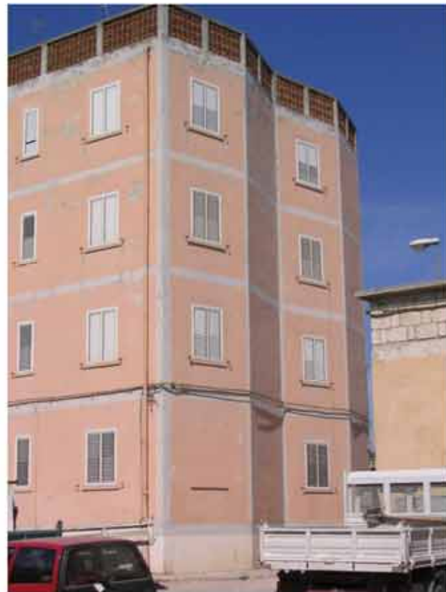
Fig. 79: prospetto laterale interno dell'edificio
