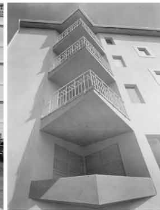
fig 29: dettaglio dei terrazzini triangolari del prospetto principale
