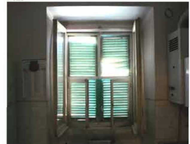
Fig. 52: stato attuale dell'infisso n.1 della finestra della cucina
