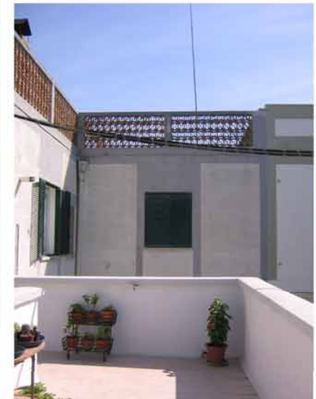
Fig. 89: vista del volume costruito in corrispondenza dell'originario terrazzo dell'alloggio di tipo A'
