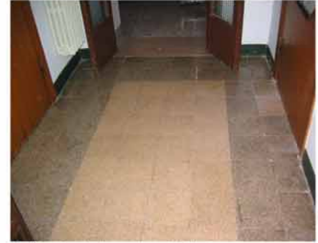
Fig. 43: pavimento di marmette granigliate di una villa A: schema di posa da prendere come riferimento per i disimpegni.
