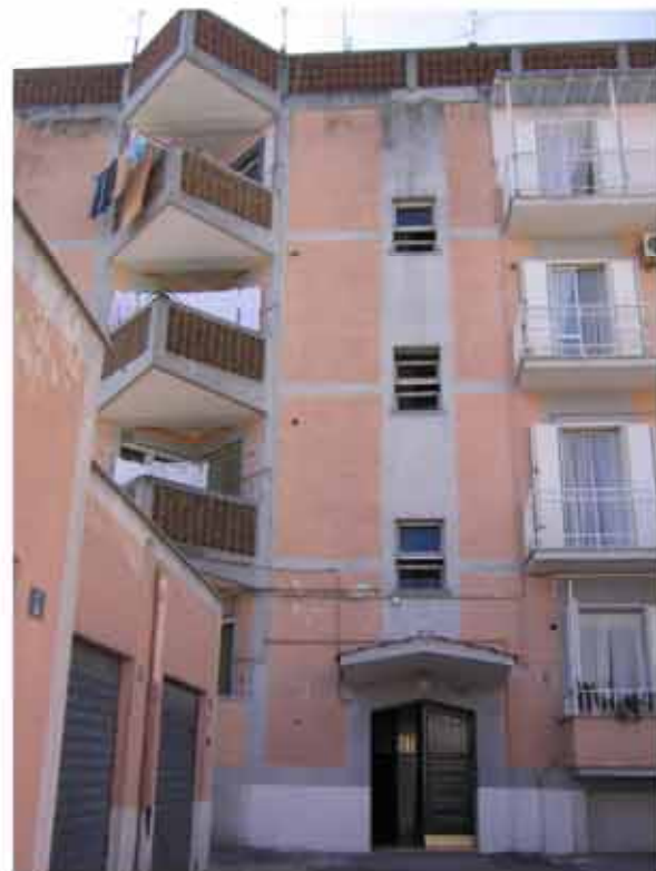
ALCUNI ESEMPI DI MANOMISSIONI E CHIUSURA CON VERANDE IN ALLUMINIO DEI TERRAZZINI TRIANGOLARI DEGLI EDIFICI IN LINEA C E C'
