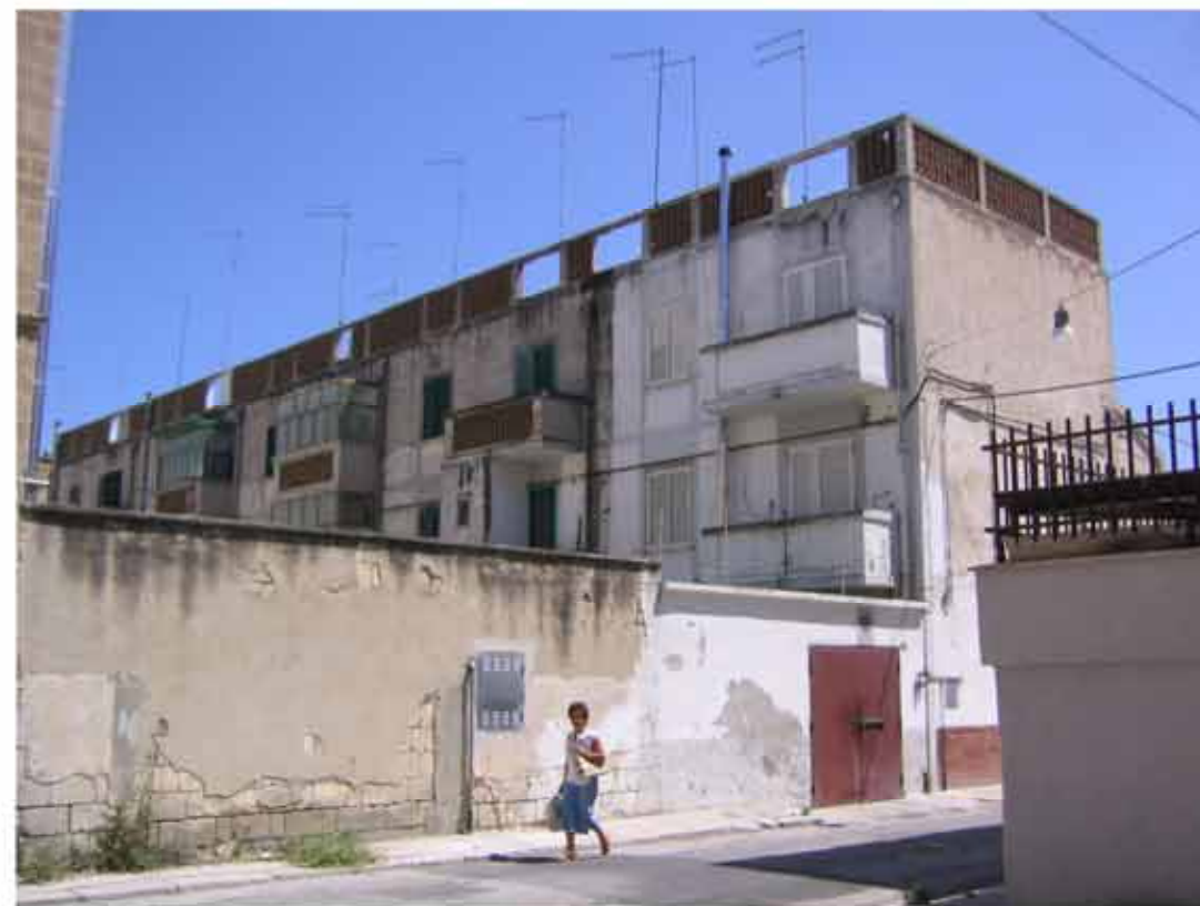
Fig. 70: prospetto laterale del secondo blocco di schiere
