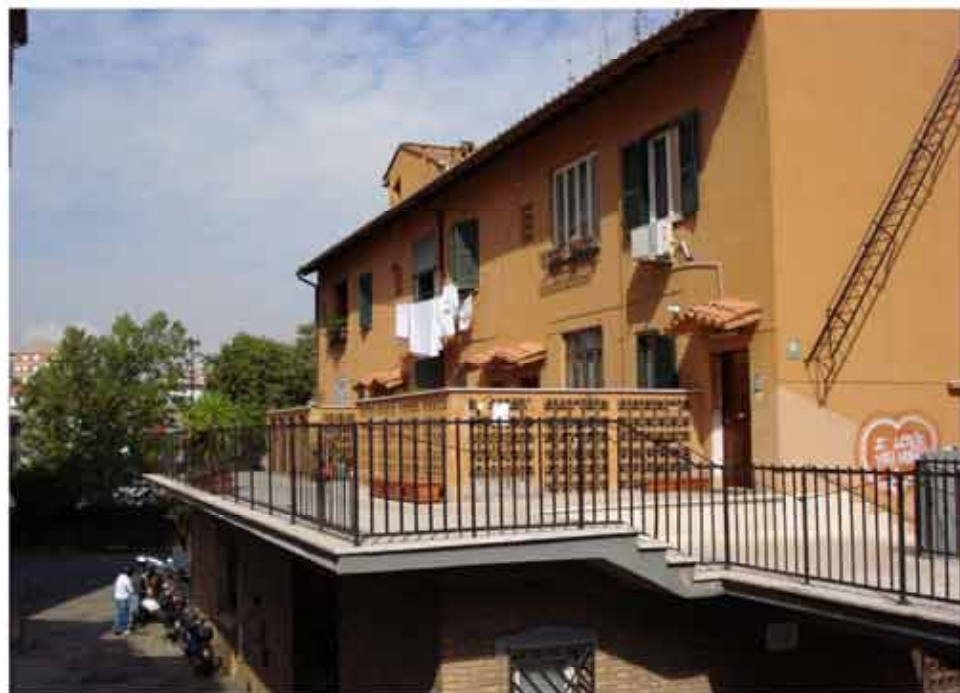
fig 16: case a schiera con ballatoio su via Diego Angeli prospetto posteriore
