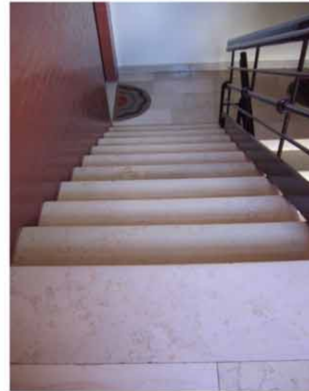
Fig. 3: rampa di scale con pianerottolo intermedio dell'edificio C
