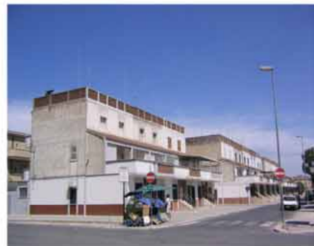
Fig. 16: ingresso al quartiere da via Pantanella
