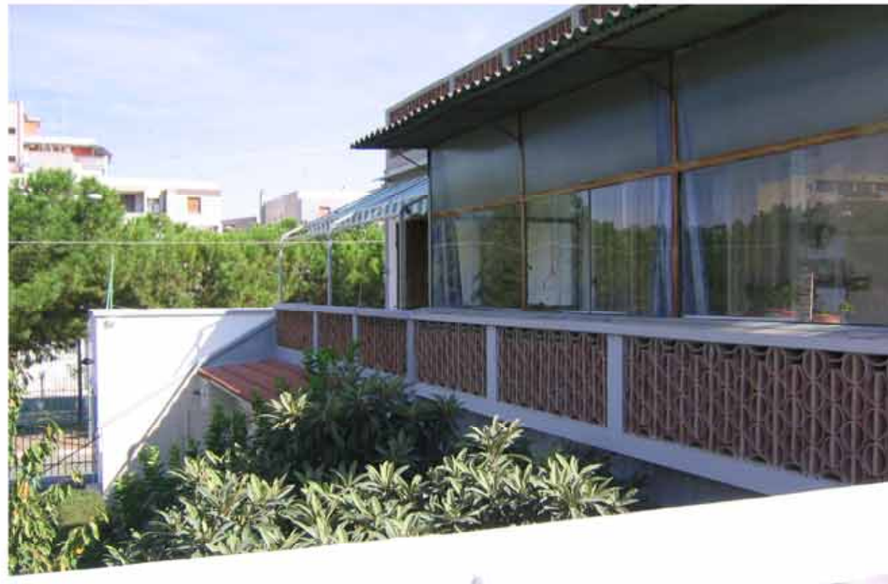
Fig. 88: ballatoio dell'alloggio di tipo A' chiuso a loggia
