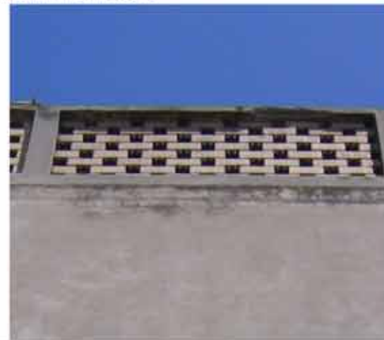
ALCUNI ESEMPI DELLO STATO DI DEGRADO DELLE BALAUSTRE IN ANELLI DI COTTO
