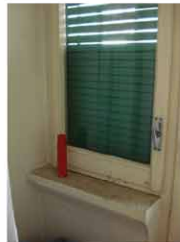
Fig. 51: stato attuale dell'infisso n.7: finestra
