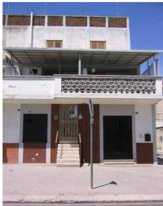
ALCUNI ESEMPI DI MANOMISSIONI E CHIUSURA CON VERANDE IN ALLUMINIO O IN MURATURA DEI TERRAZZINI E DEI TERRAZZI DEGLI EDIFICI IN LINEA DE
