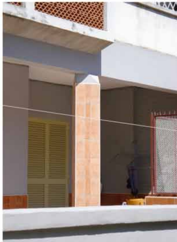
Fig. 93: particolare del pilastro sagomato del portico
