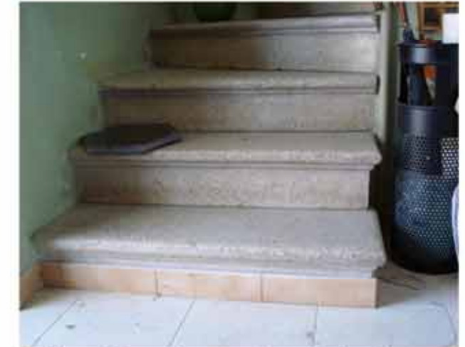
Fig. 30: scala interna di accesso al secondo piano in cemento granigliato
