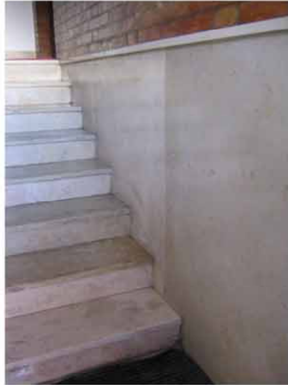
Fig. 1: prima rampa di scale dell'edificio C: rivestimento in pietra di Trani
