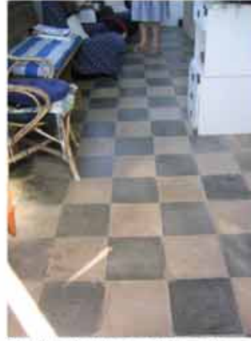
Fig. 41: pavimento di marmette colorate in pasta originali di una villa A. schema di posa da prendere come riferimento
