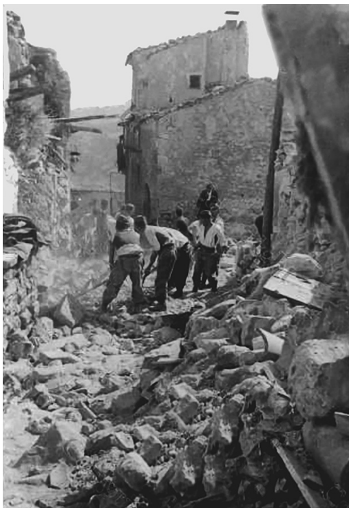
Fig. 2. Immagine del paese in seguito al terremoto del settembre 1933.
