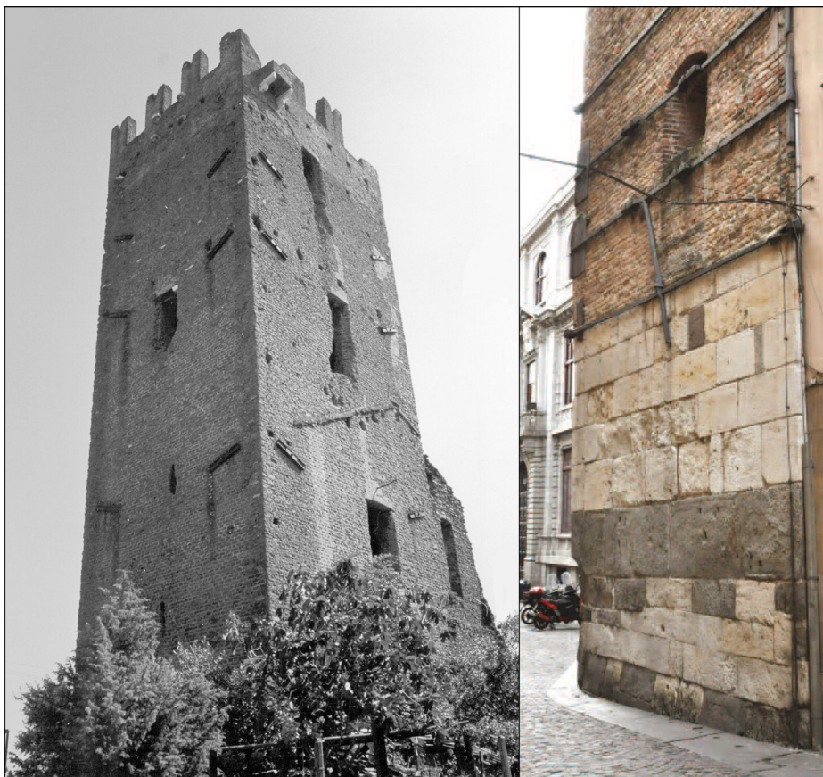
Figura 3. A sinistra, la torre del casale dei Santi Quattro Coronati (Roma): struttura a pianta rettangolare (6,80 x 6 m ca.) e altezza di circa 20 m. A destra, la torre di Bo (Padova), particolare del basamento della costruzione (immagini tratte da S. Carocci e M. Vendittelli, L'origine della Campagna Romana... , op. cit., Fig. 19; A. Chavarría Arnau (ed.), Padova... , op. cit., p. 30.
