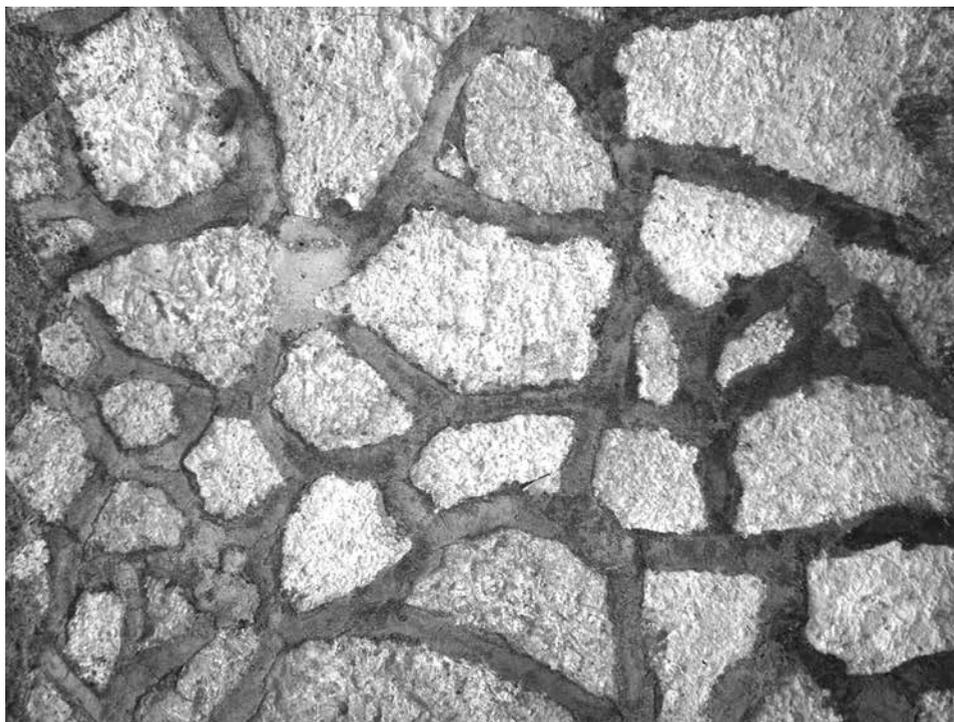
Fig. 7. VEIO, Campetti area sud-ovest. Particolare dei frammenti della volta antica cementati all'interno del restauro moderno (foto Autore).
