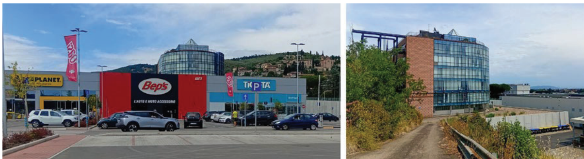
Fig. 5 Attuale assetto dell'ex area produttiva Ellesse (fonte: foto dell'autrice).
