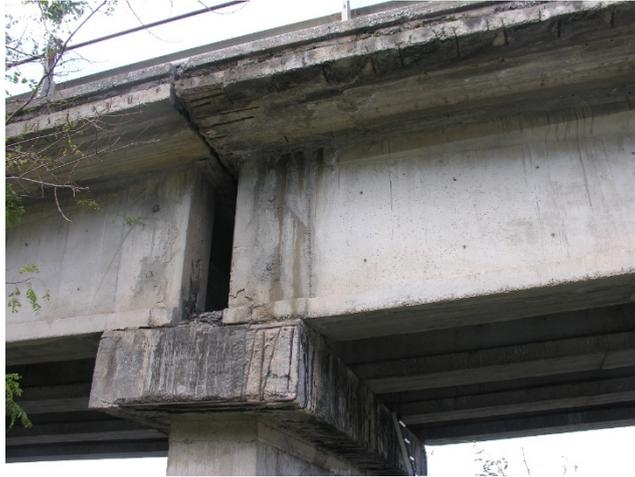
*Figura 2.12: Ammaloramento del cls con ferri esposti dovuti alla percolazione di acqua dal giunto.*
