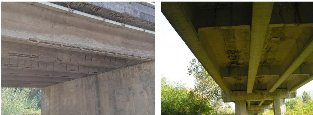
*Figura 2.14: Stato di degrado diffuso in travi e solette.*
