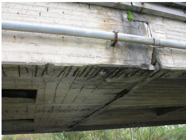
*Figura 2.17: Sella Gerber non ispezionabile con armature esposte nelle travi.*
