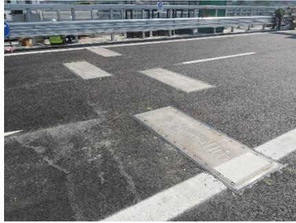
Figura 3.14: Piastre di pesatura dinamica installati nel ponte San Giorgio. Le foto sono state fornite da Cetena S.p.a. e Fincantieri.
