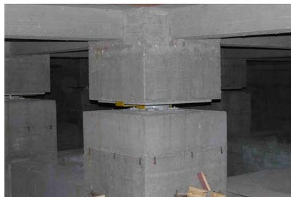
Figura 5.4: Isolatore a scorrimento con superficie piana.
