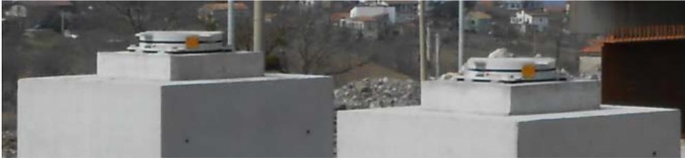
Figura 5.10: Viadotto "Pian della Menta": isolatori a scorrimento a doppia superficie curva (per gentile concessione di MATILDI+PARTNERS e FIP mec).
