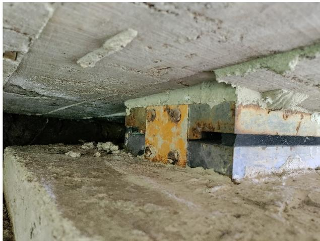
*Figura 2.18: Appoggi, assenza di rimozione dei sistemi di bloccaggio.*
