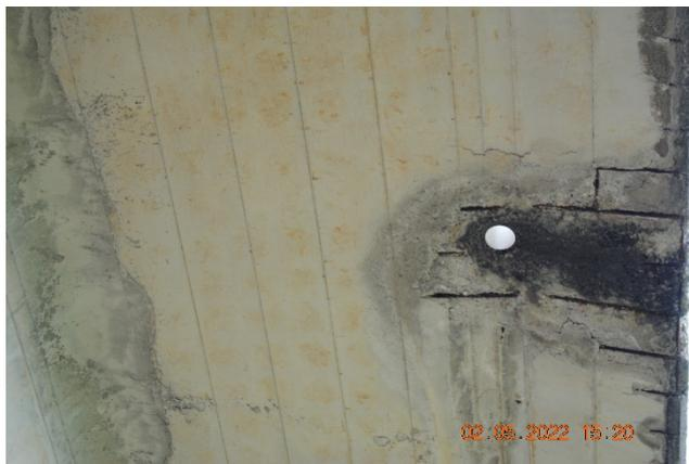
*Figura 2.13: Assenza di scarichi per il convogliamento a valle dell'acqua di piattaforma.*
