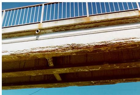
Figura 4.4: Civita di Bagnoregio, ammaloramento del calcestruzzo ed armature esposte e corrose.
