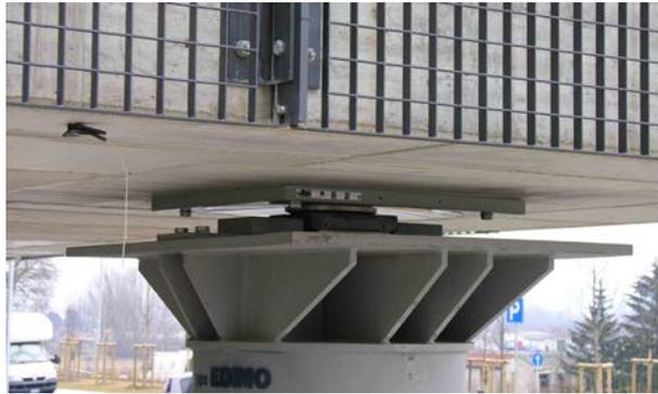
Figura 5.5: Isolatore a scorrimento con superficie curva.
