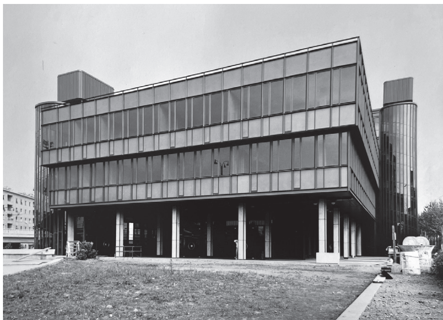
Fig. 18 - Il complesso edilizio completato (ACS, FL, b. 70)
