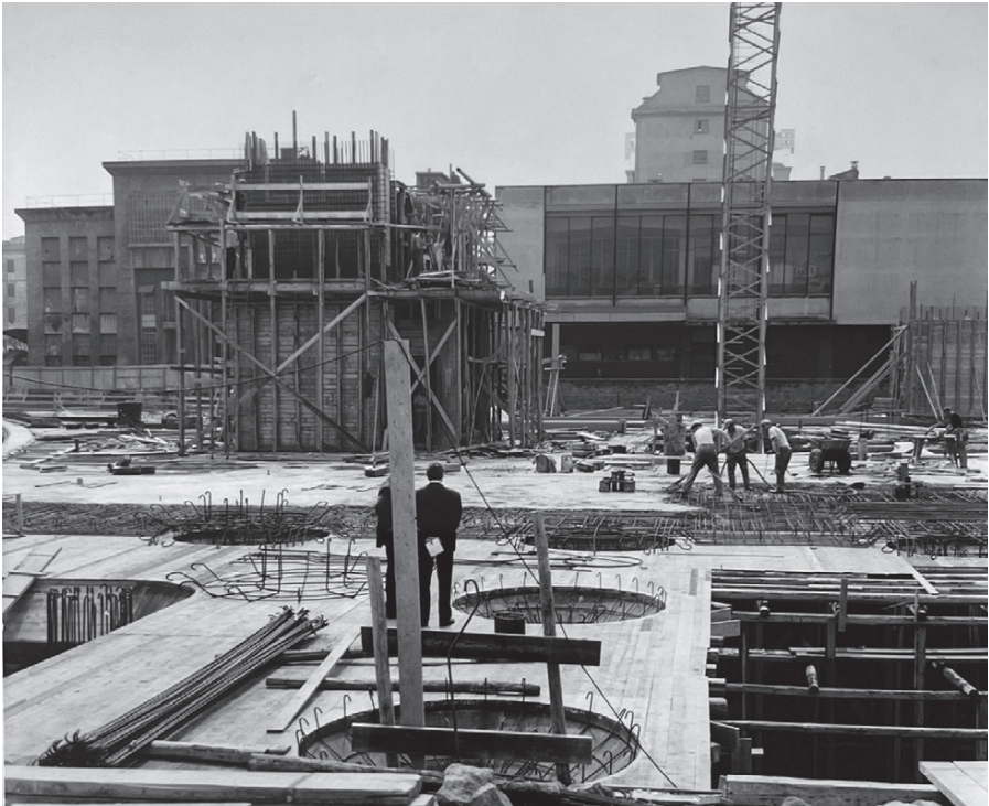
Figg. 13-16 - Viste del cantiere (ACS, FL, b. 70)
