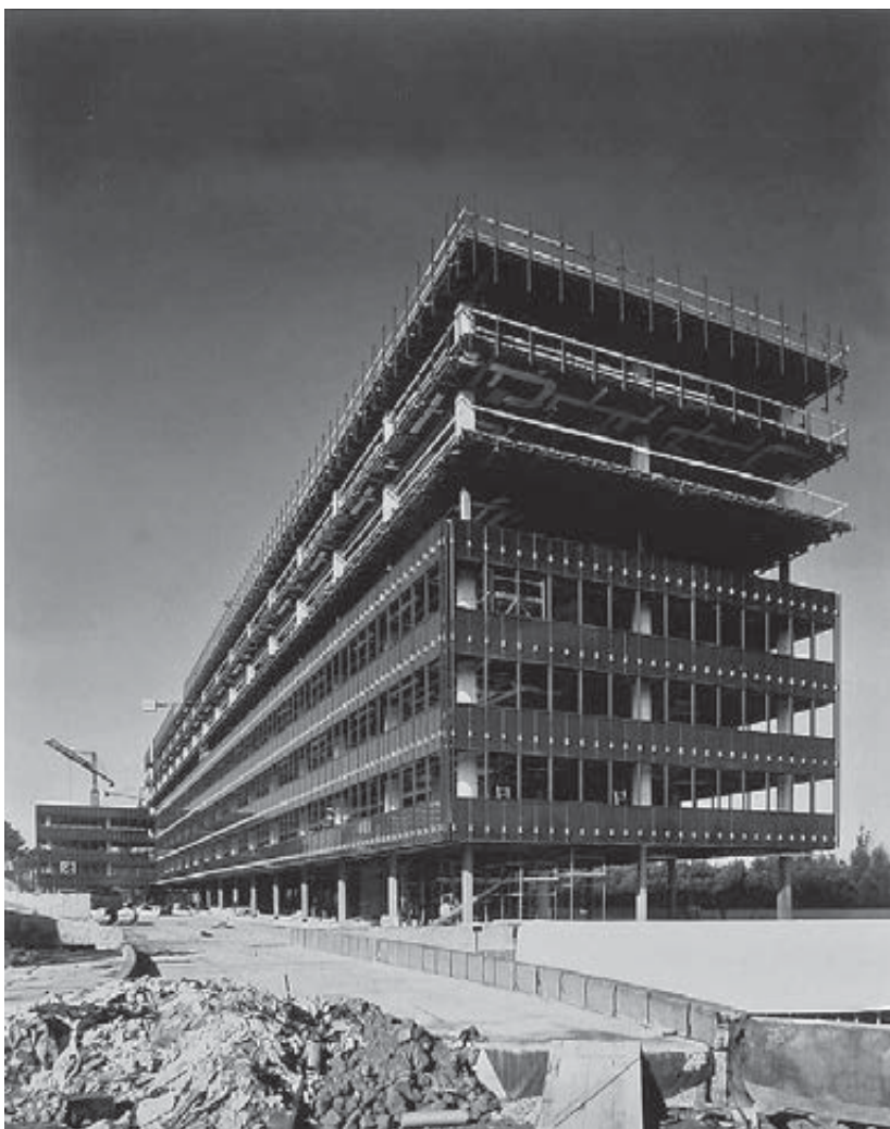
Fig. 20 - Uffici della Esso, montaggio delle pareti vetrate in fase avanzata, febbraio 1966. Sono messi in opera i telai delle finestre e le sottofinestre del corpo principale. In sommità si vedono i montanti di sostegno dei pannelli di coronamento (ACS, SGIS, Album fotografici, b. 16)
