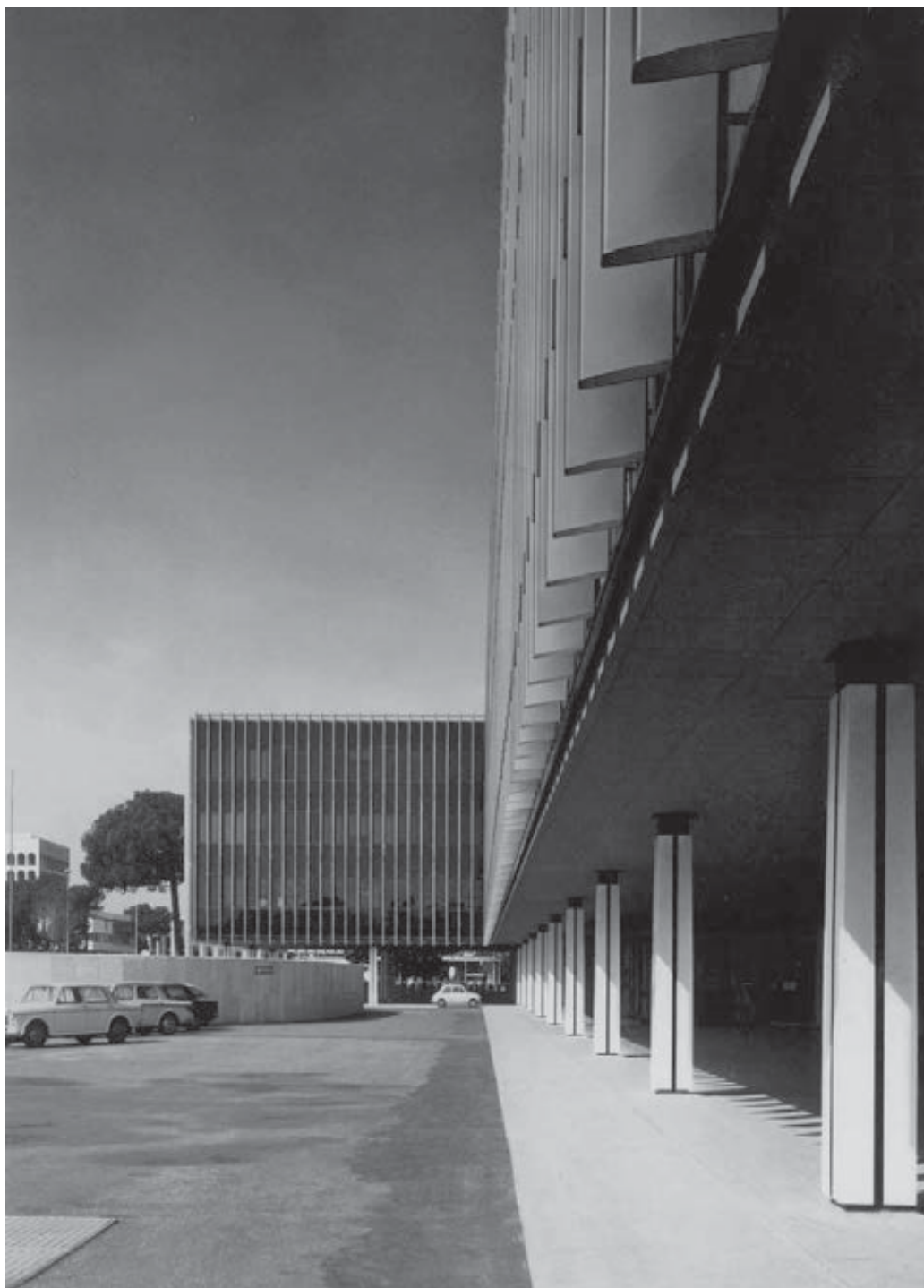
Fig. 10 - Uffici della Esso, il piano d'ingresso. I pilastri sono contornati da quattro cantonali di acciaio (ACS, LM, Provini fotografici, 03600)
