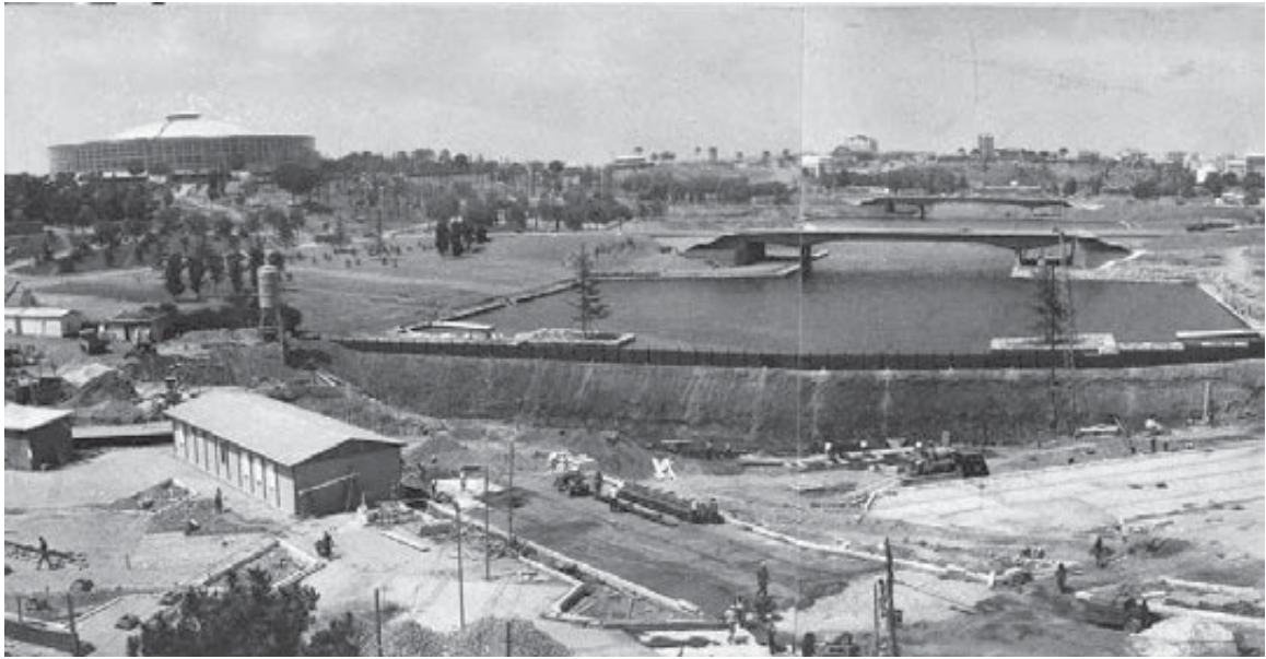
Fig. 5 - Il cantiere all'inizio dei lavori, luglio 1960 (ASE)
