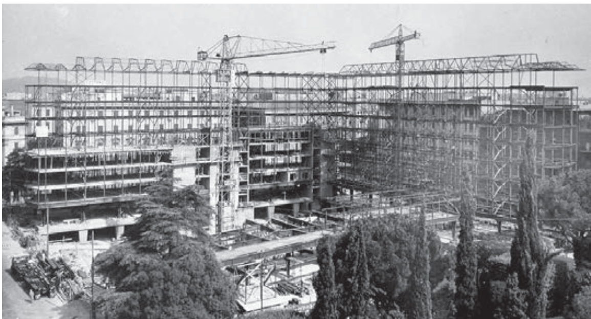
Fig. 5 - L'edificio in fase di costruzione (AB)
