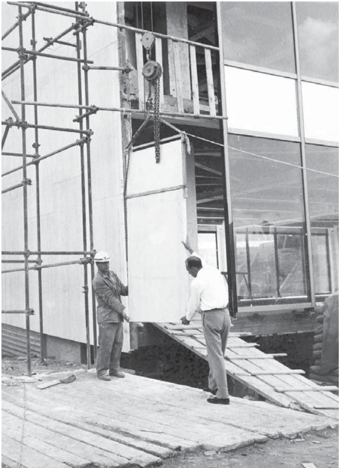
Fig. 11 - Montaggio delle lastre di travertino sui lati dell'edificio, ottobre 1961 (ASE)
