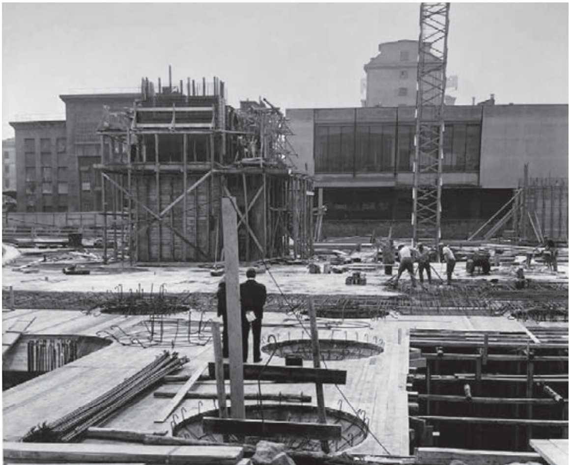
Fig. 13-16 - Viste del cantiere (ACS, FL, b. 70)
