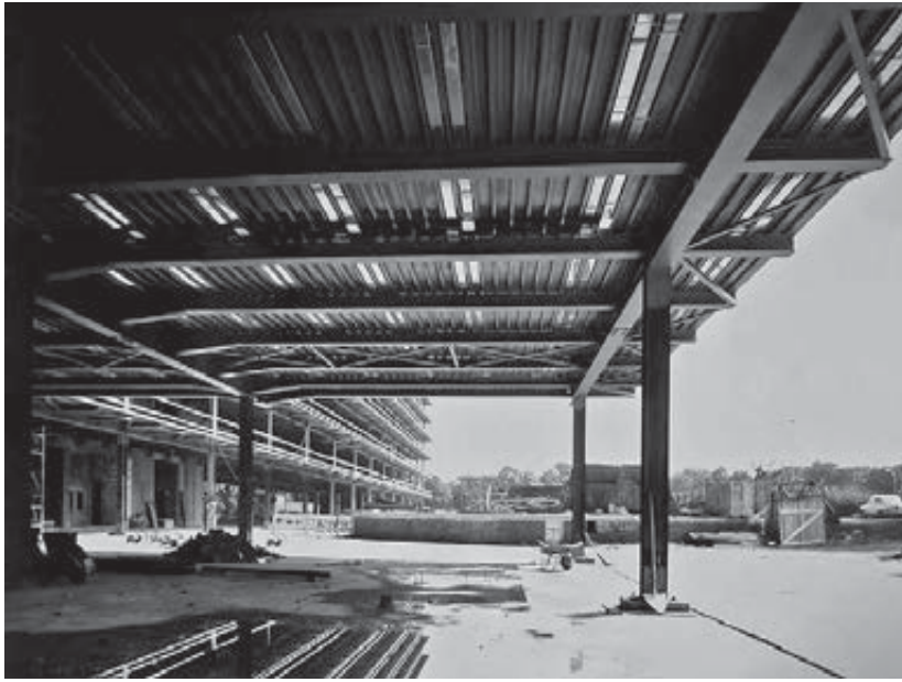
Fig. 8 - Uffici della Esso, la struttura di acciaio ormai ultimata, 18 settembre 1965 (ACS, SGIS, Album fotografici, b. 16)
