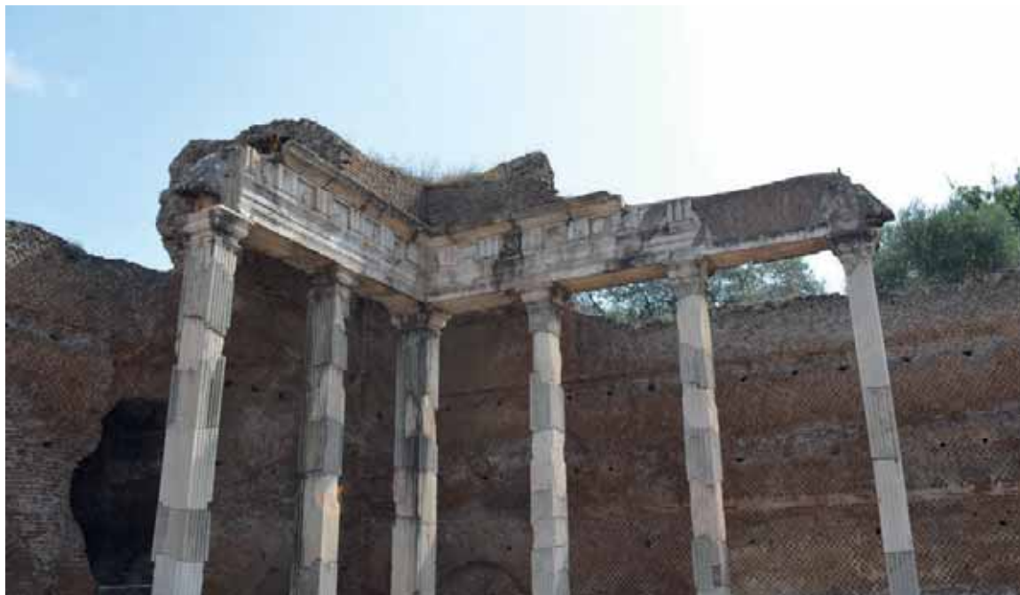
Fig. 11 - Villa Adriana, cd. Sala dei Pilastri Dorici, anastilosi di una porzione dei pilastri; sul primo a destra è ben visibile una delle piattabande armate.
