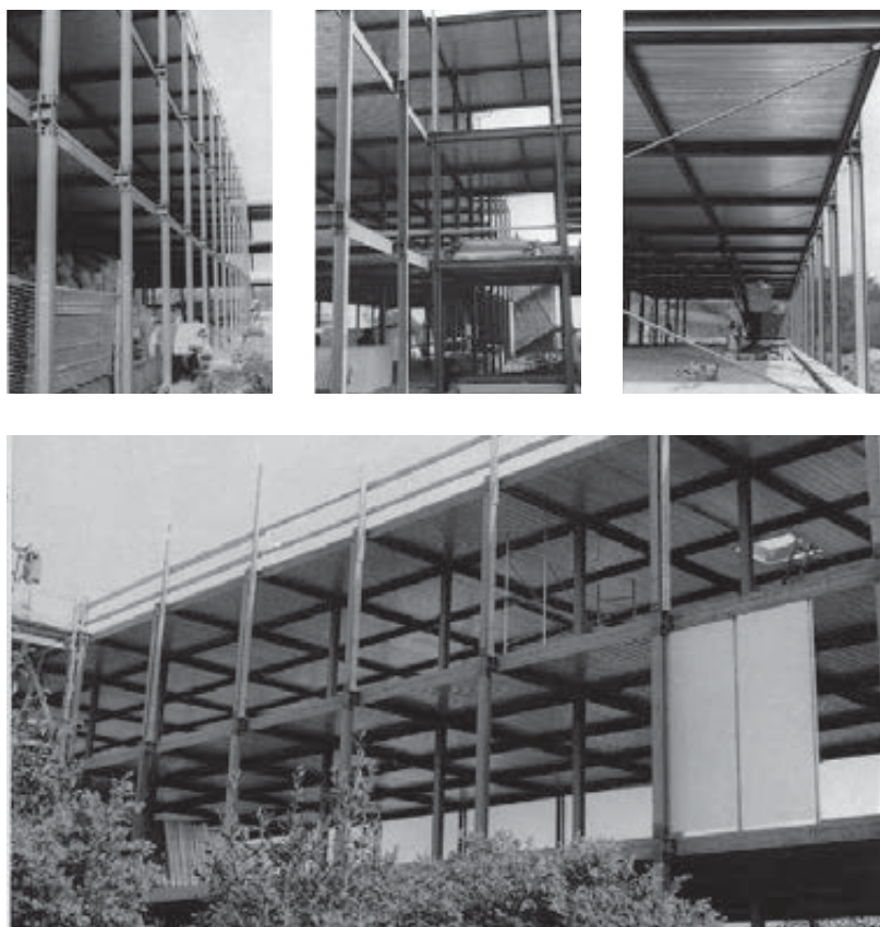
Fig. 13 - Cantiere dell'Istituto tecnico industriale di Velletri: fasi di montaggio della struttura del sistema per scuole pluripiano, allestimento dei pannelli-parete, 1965 (ACS, PB)
