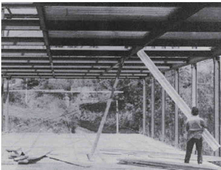
Figg. 10-12 - Cantiere dell'Istituto tecnico industriale di Velletri: fasi di montaggio della struttura del sistema per scuole pluripiano, allestimento dei solai modulari in lamiera grecata, 1965 (ACS, PB)
