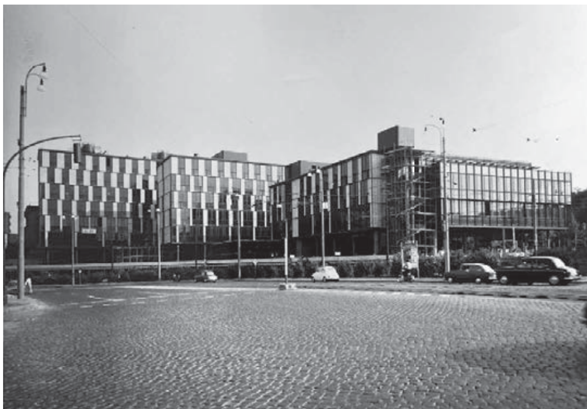
Fig. 29 - Il complesso edilizio in fase di completamento (ACS, FL, b. 70)
