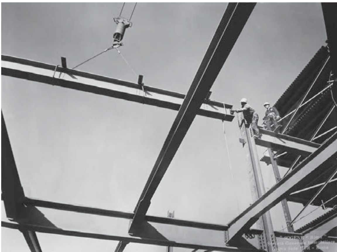
Fig. 7 - Uffici dell'Immobiliare, montaggio di una trave di spina della struttura di acciaio (ACS, SGIS, Album fotografici, b. 16)
