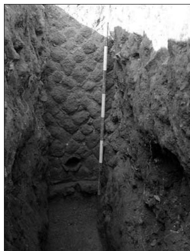
Fig. 12. Veio, Campetti area sud-ovest, particolare del foro per il drenaggio dell'acqua piovana (foto di U. Fusco).
