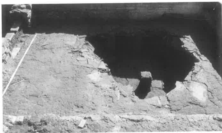
Fig. 26. Particolare dell'impianto termale della terrazza superiore
