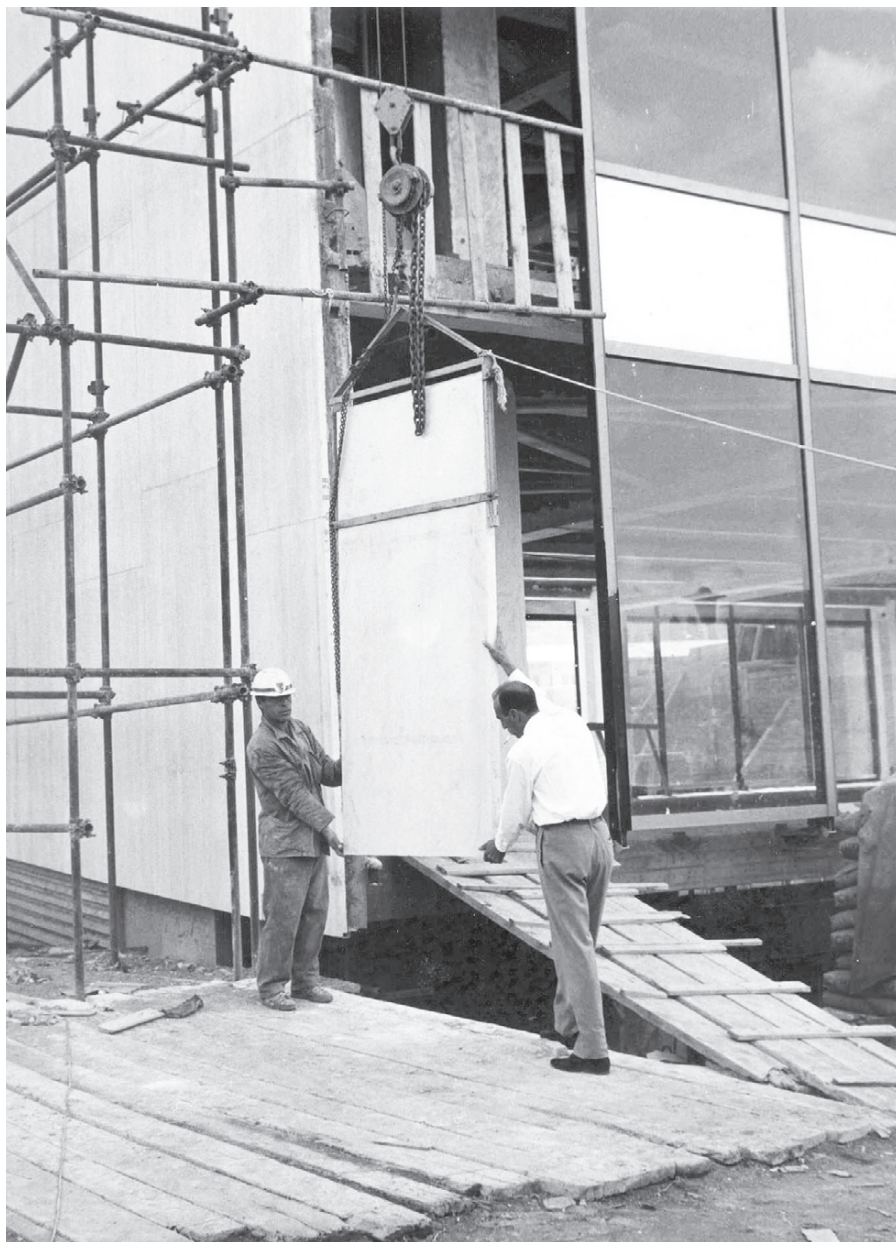
Fig. 11 - Montaggio delle lastre di travertino sui lati dell'edificio, ottobre 1961 (ASE)
