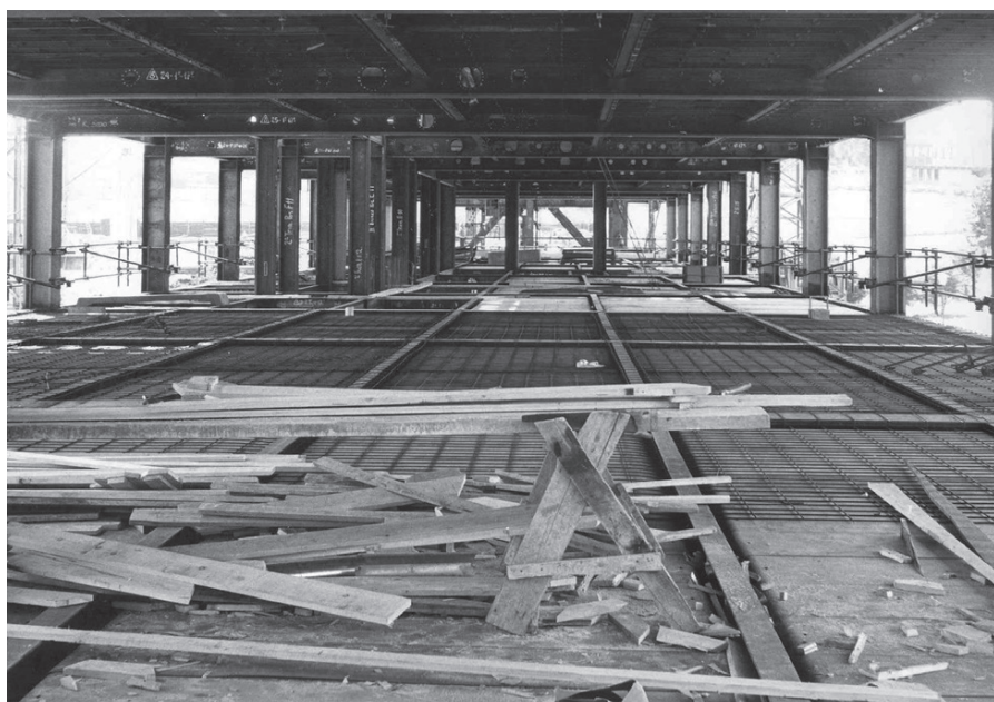
Fig. 8 - Il cantiere nel mese di maggio 1961, in una fase che precede il getto dei solai (ASE)
