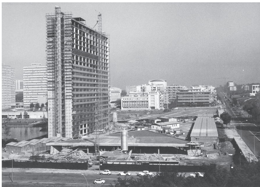
Fig. 14 - Vista del cantiere con la facciata in fase di completamento, ottobre 1961 (ASE)
