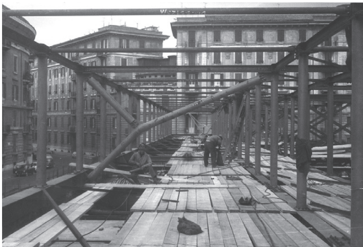
Fig. 10 - La struttura metallica in fase di montaggio (AB)
