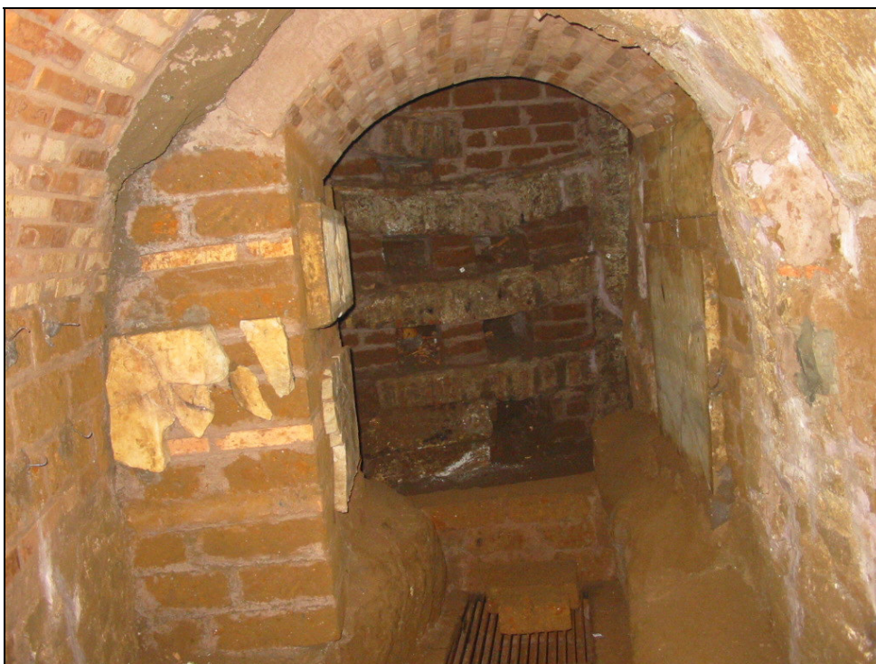
Figura 29 - Cimitero dei Giordani. Passaggio tra il cubicolo Bd e il cubicolo Be.
