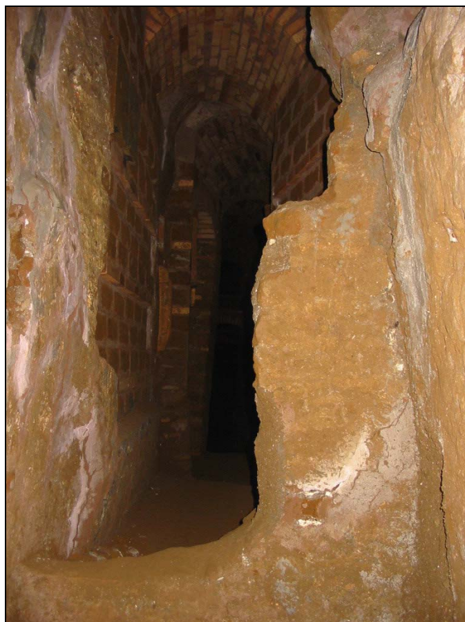
Figura 28 - Cimitero dei Giordani. Iter devozionale. Muro sbarramento galleria b3.
