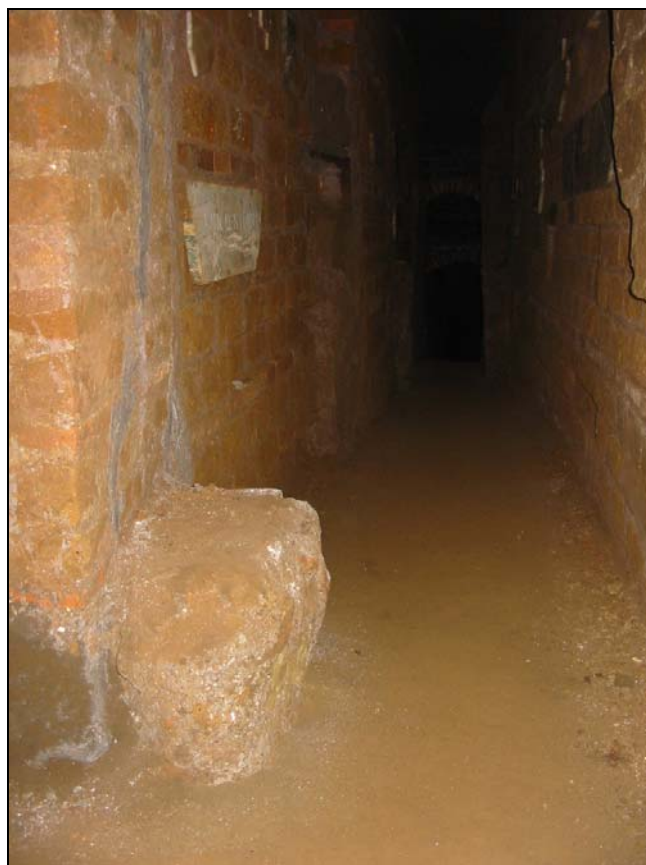
Figura 27 - Cimitero dei Giordani. Iter devozionale. Muro sbarramento galleria b2.
