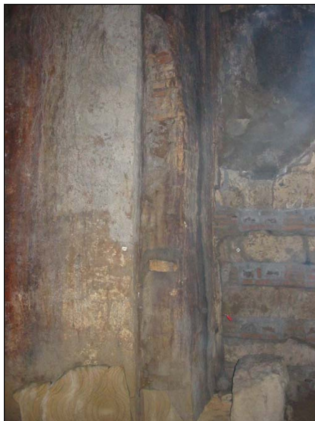
Figura 13 - Catacomba di Massimo. Basilica ipogea. Pilastro posizionato nell'angolo nord-ovest.
