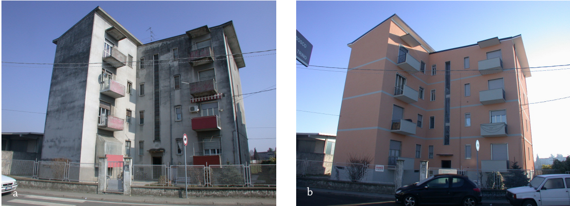
Fig. 29: Restauro della facciata di una palazzina di edilizia economico-popolare: a), b) prima e dopo il restauro 30
