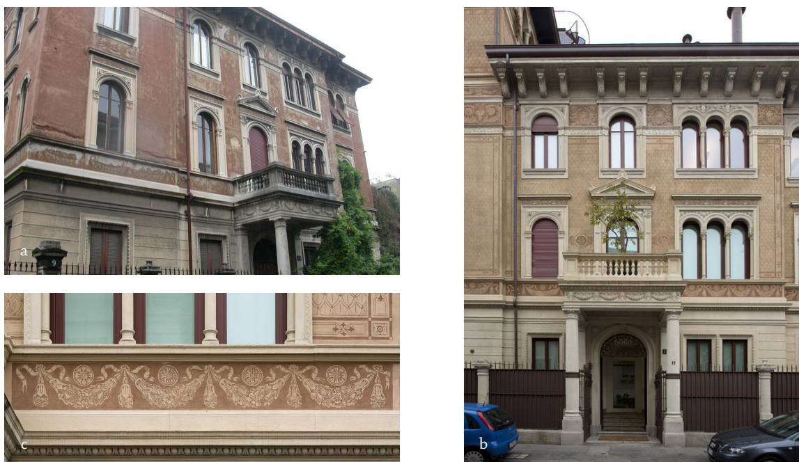
Fig. 28: Restauro della facciata di una villa d'epoca: a), b) prima e dopo il restauro; c) dettaglio del graffito ricostruito 29
