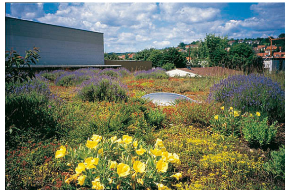
Fig. 27: Tetto verde intensivo
