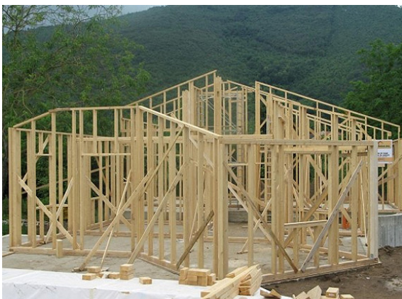
Fig. 22: Edificio con struttura a telaio ligneo
