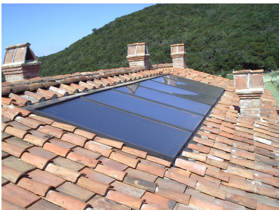
Fig. 34: Collettori solari termici integrati nel manto di copertura
