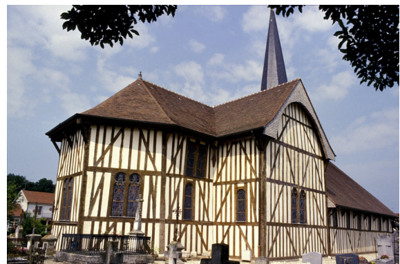
Fig. 10: Edificio realizzato con la tecnica del torchis
