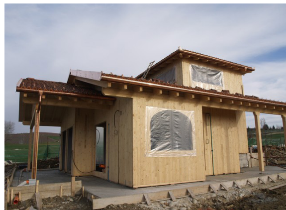
Fig. 23: Edificio con struttura in X-LAM a Novello (CN)
