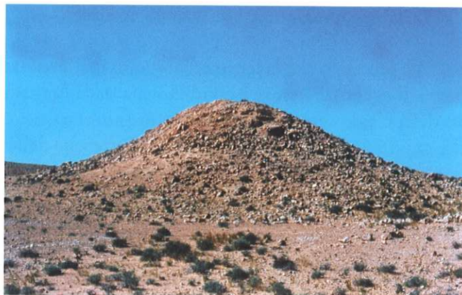
Fig. 18. – Gasr TRG 16: accumulo di detriti edilizi.
