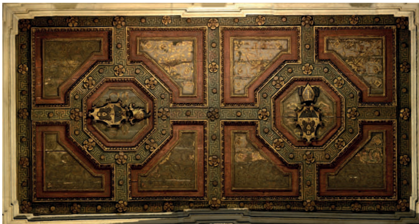
33 – ROMA, PALAZZO DELLA VALLE – SOFFITTO DEL PIANEROTTOLO DELLA SCALA D'ONORE CON FUNZIONE DI VESTIBOLO (rilievo mediante fotogrammetria digitale, Leonardo Baglioni e Lorenzo Grieco)
