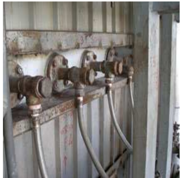
Figura 6.8: valvola regolatrice del vapore (a sinistra) e lance di immissione dell'ammoniaca (a destra)
