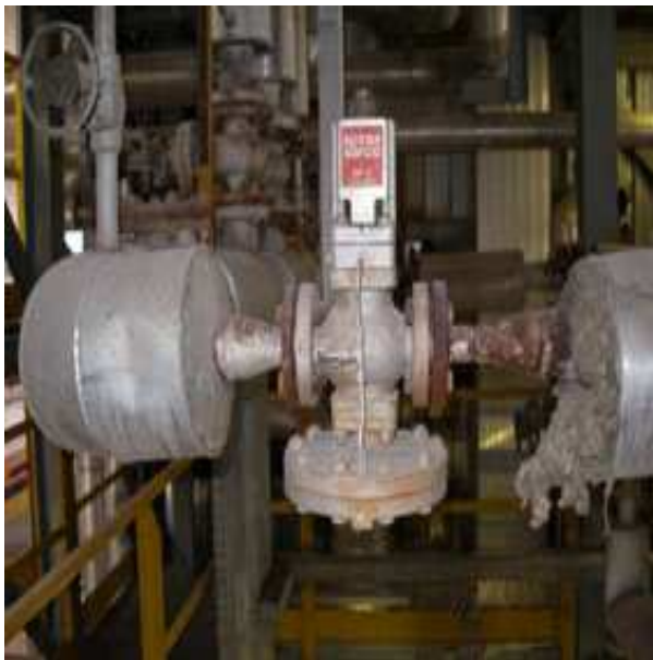
Figura 6.8: valvola regolatrice del vapore (a sinistra) e lance di immissione dell'ammoniaca (a destra)
