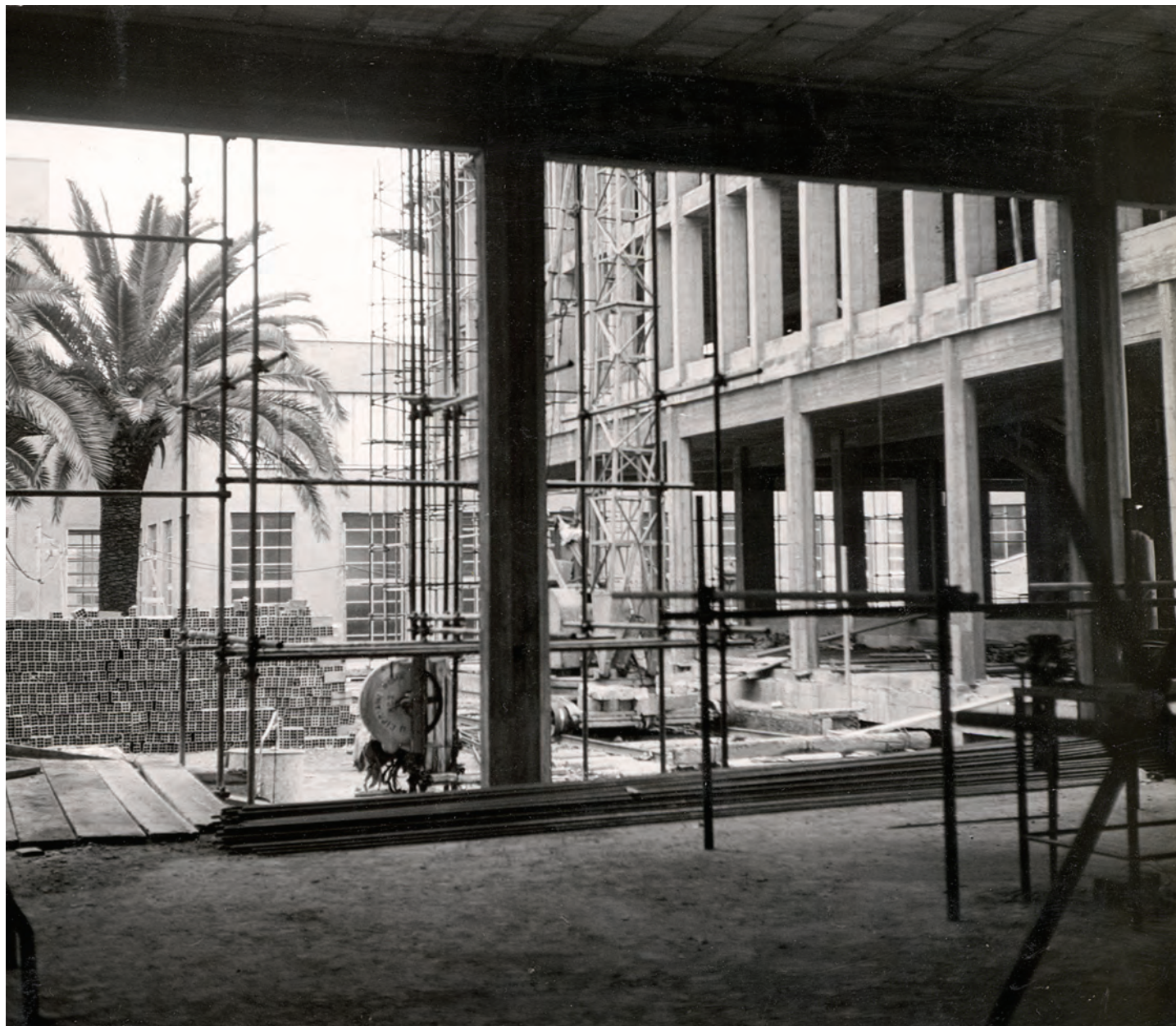
20. Istituto di chimica farmaceutica e tossicologia. Foto di cantiere (Asg, R I, p. 2b).
