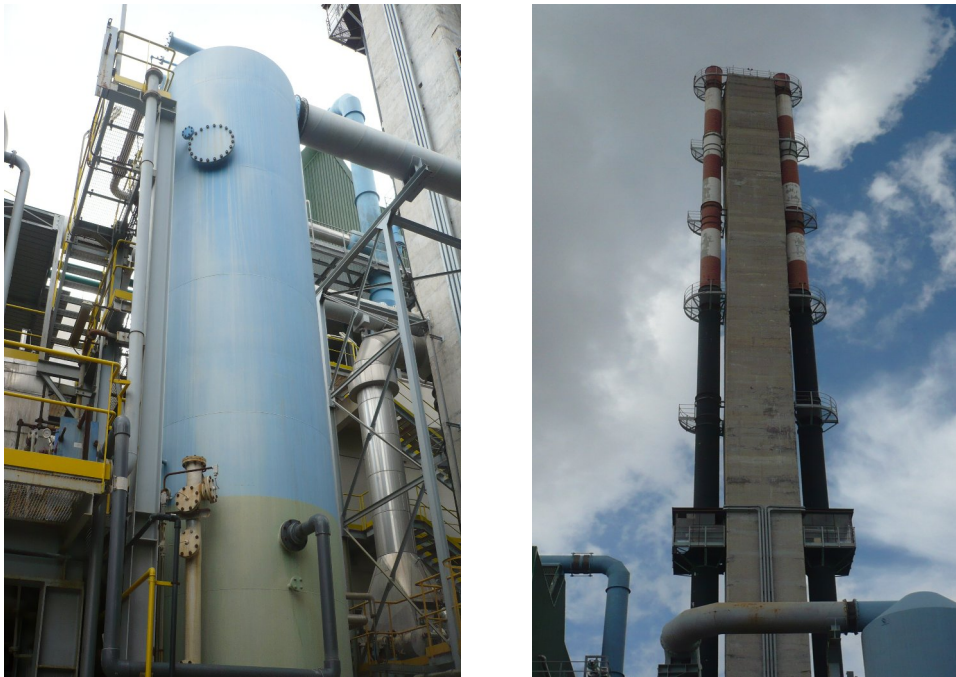
Figura 5.5: Torre di lavaggio e camino bicanna per l'evacuazione fumi
