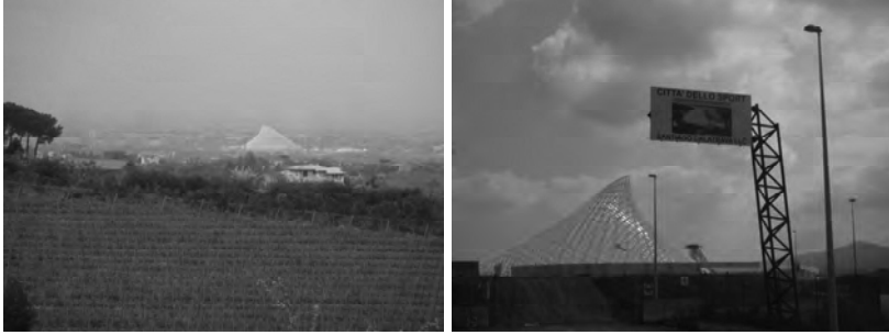
Figg. 2 e 3 - Lo stato dell'arte del «progetto Calatrava»
