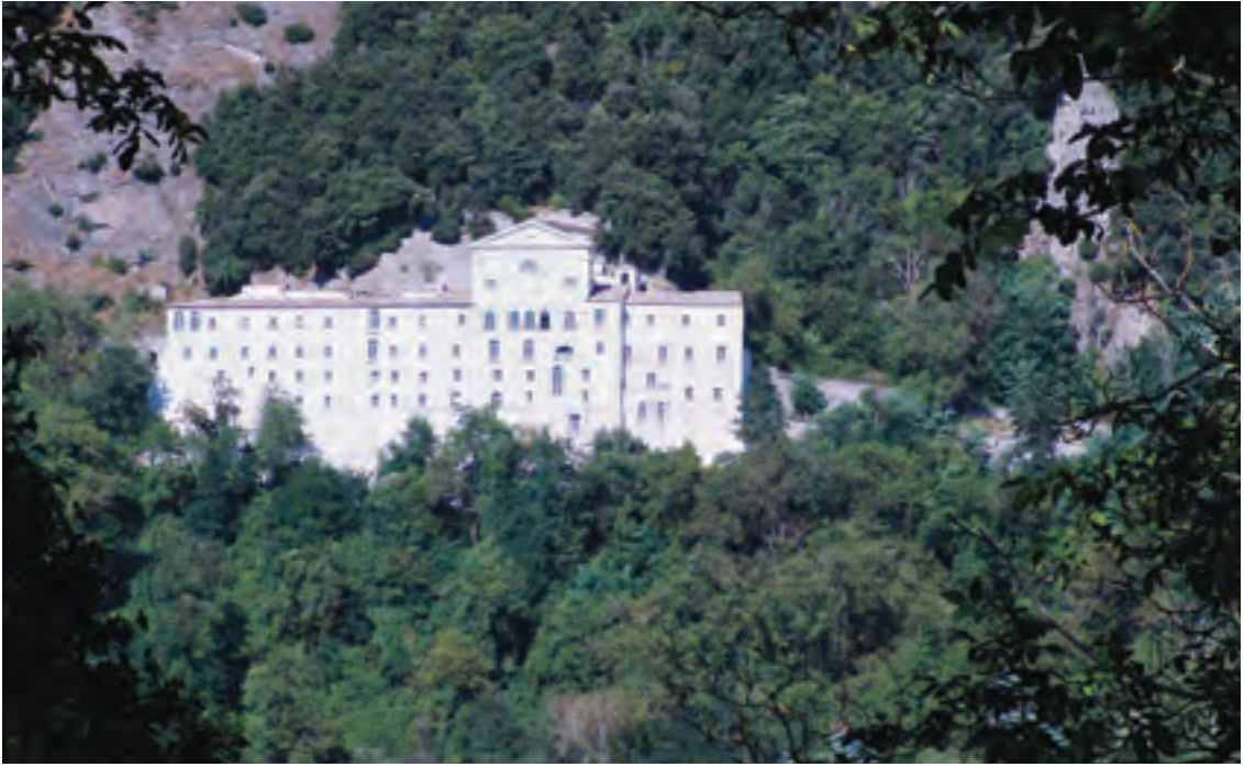
Rionero in Vulture A lato, i fitti boschi che caratterizzano il Vulture
