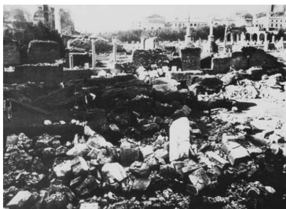
Fig. 6 - Stratigrafie di crollo nella basilica Aemilia/Pauli durante i lavori di recupero (da C. Morselli – E. Tortorici)
